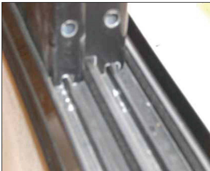
Abbildung A4-5: Typisches Fenster in Syrien. Aluminiumfenster mit Schiebsystem und Einfachverglasung.
