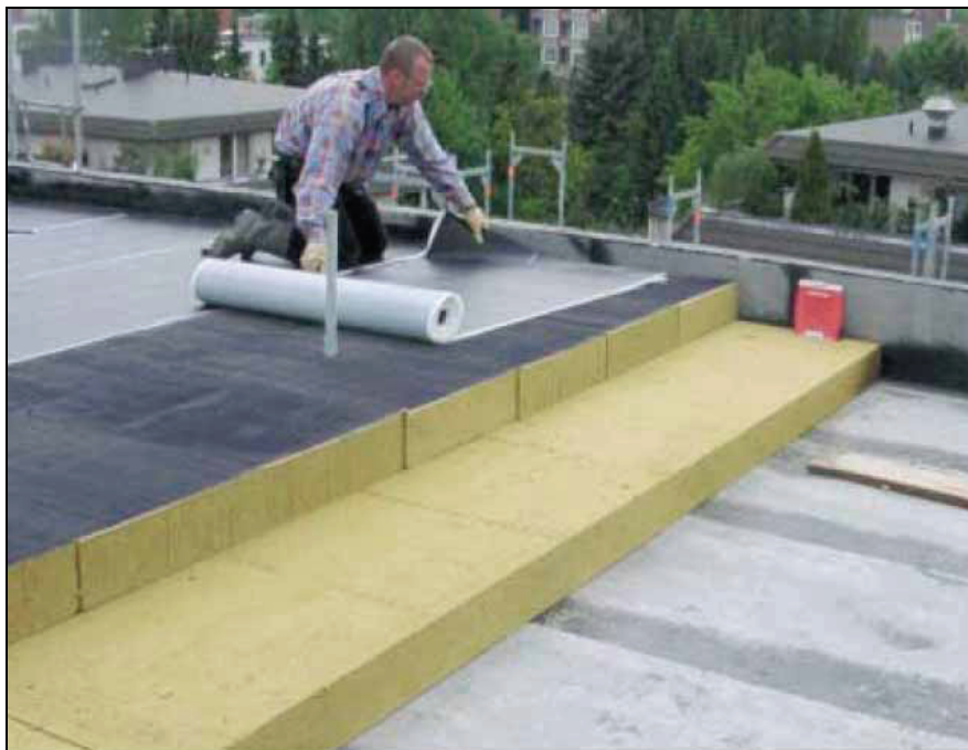
Abbildung A6-4: Beispiel für Flachdachdämmung mit Abdichtungsmaßnahmen.
