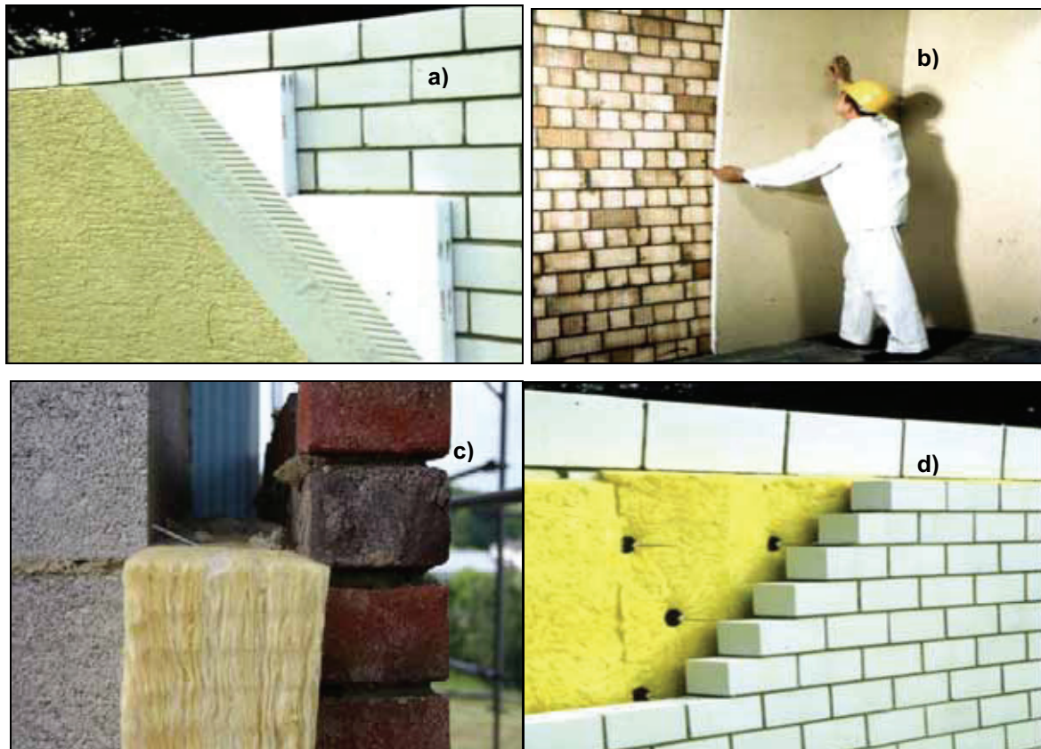
Abbildung A6-1: Anwendungsbeispiele für Wärmedämmung von Außenwänden. a) Außendämmung, b) Innendämmung, c) Kerndämmung ohne Luftschicht, und d) Dämmung mit hinterlüfteter Vorschale [SEUNIG, 2004].
