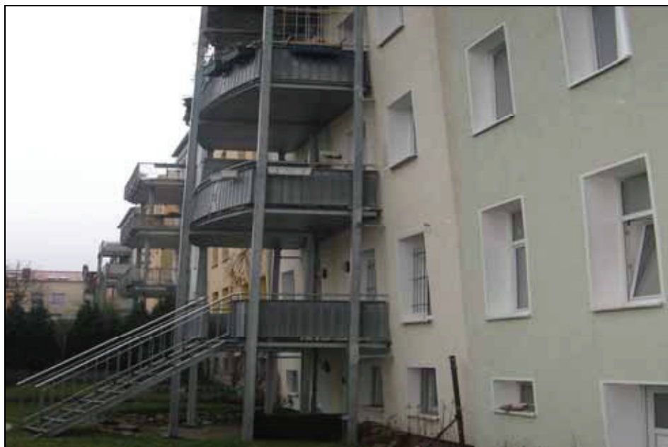
Abbildung A6-12: Ein vor die Fassade gestellter Balkon kann eine optimale Lösung zur Vermeidung der aus auskragendem Stahlbeton entstehenden Wärmebrücken darstellen [Gebäude 6, Waldemarstraße, Rostock].
