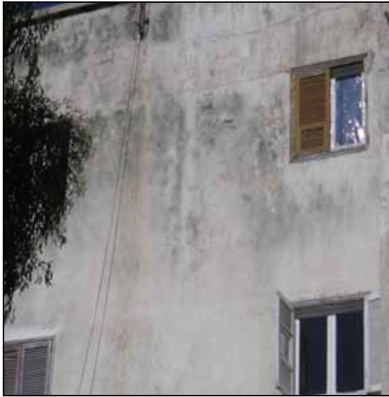
Abbildung A2-5: Feuchteschäden und ästhetische Probleme an Gebäuden in Syrien, wodurch hohe Sanierungskosten entstehen (Beispiel Lattakia).
