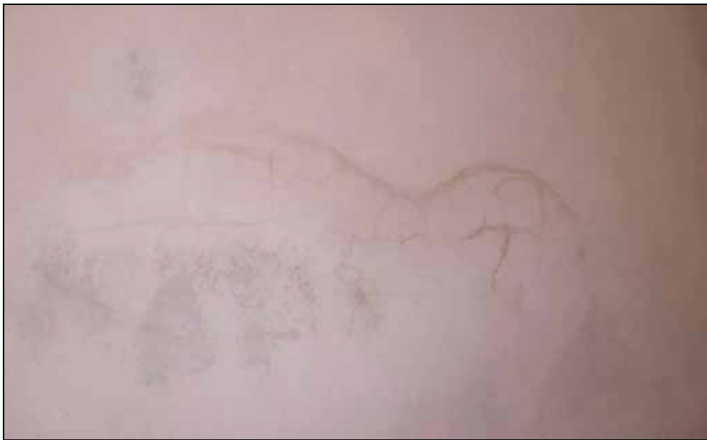
Abbildung A9-3: Beispiel für Feuchteprobleme an einer Innenoberfläche einer west-orientierten Außenwand einer Wohnung in Lattakia aufgrund der klimatischen Umgebungswirkung.
