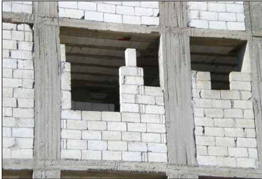
Abbildung A2-3: Typisches Rohbauverfahren in Syrien: Stahlbetonskelett, Wände mit Hohlblocksteinen ausgemauert, Decke bzw. Dach als Stahlsteinplatte.
