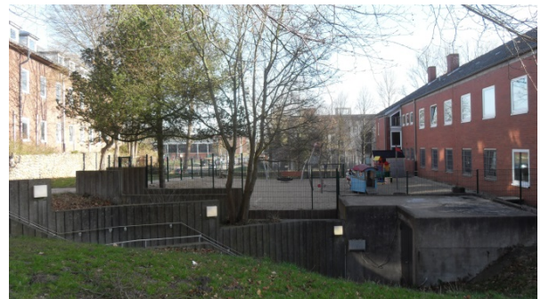
Abb. 28: Kindertagesstätte zwischen Bürogebäuden
