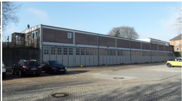
Abb. 8: Technischer Bereich mit Fahrzeughallen
