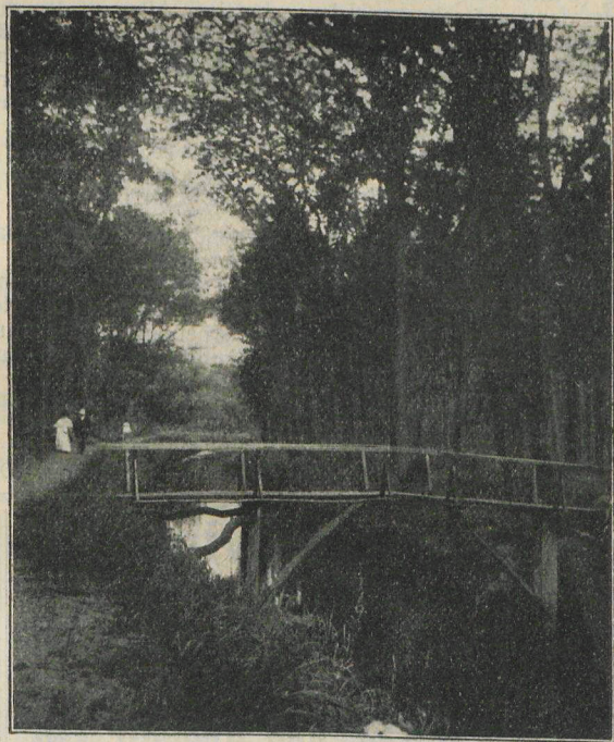
Kanalbrücke bei Markgrafenheide.
