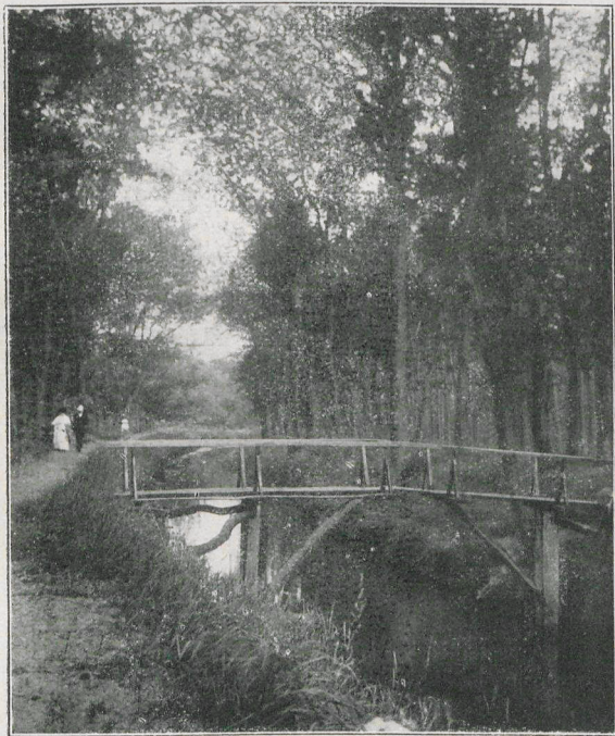
Kanalbrücke bei Markgrafenheide.
