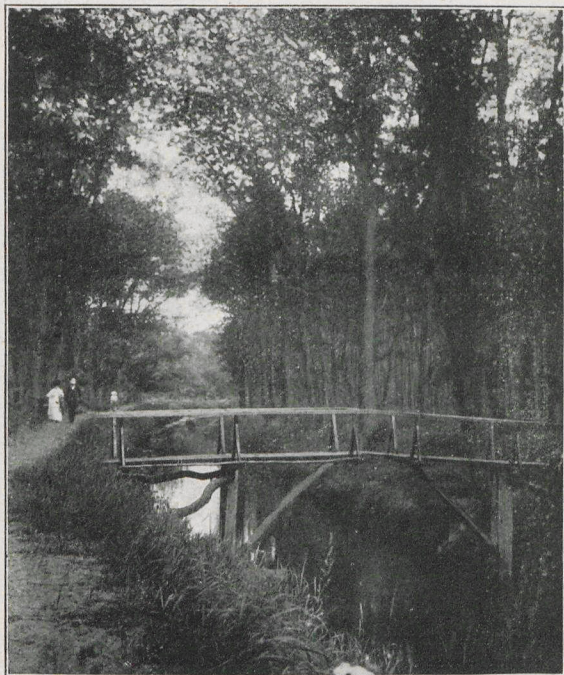
Kanalbrücke bei Markgrafenheide.
