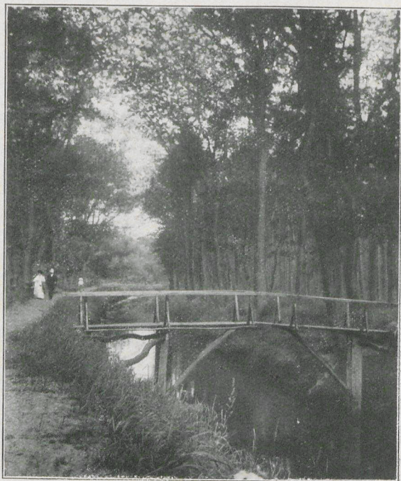
Kanalbrücke bei Markgrafenheide.
