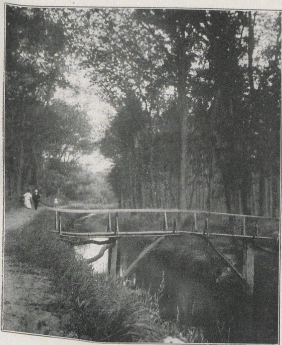
Kanalbrücke bei Markgrafenheide.
