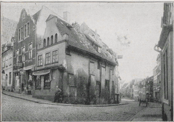
Giebelhäuser an der Gr. Wasserstraße.
