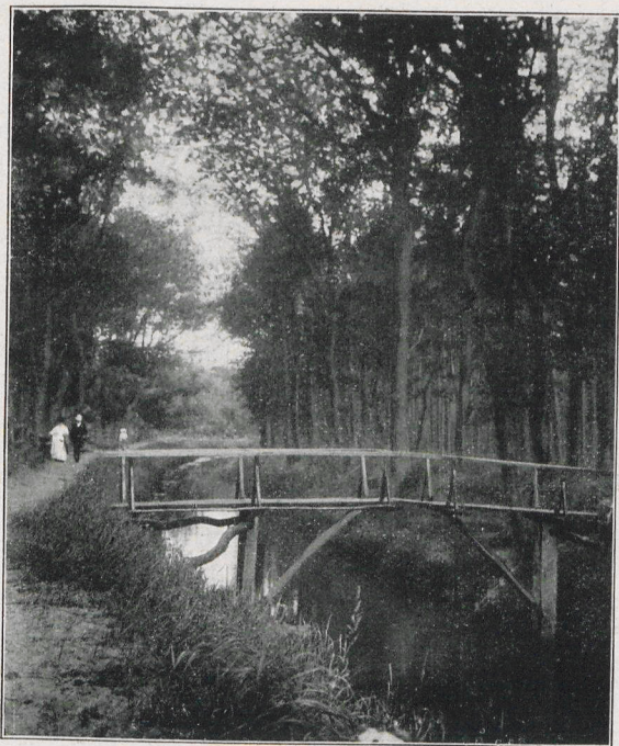
Kanalbrücke bei Markgrafenheide.
