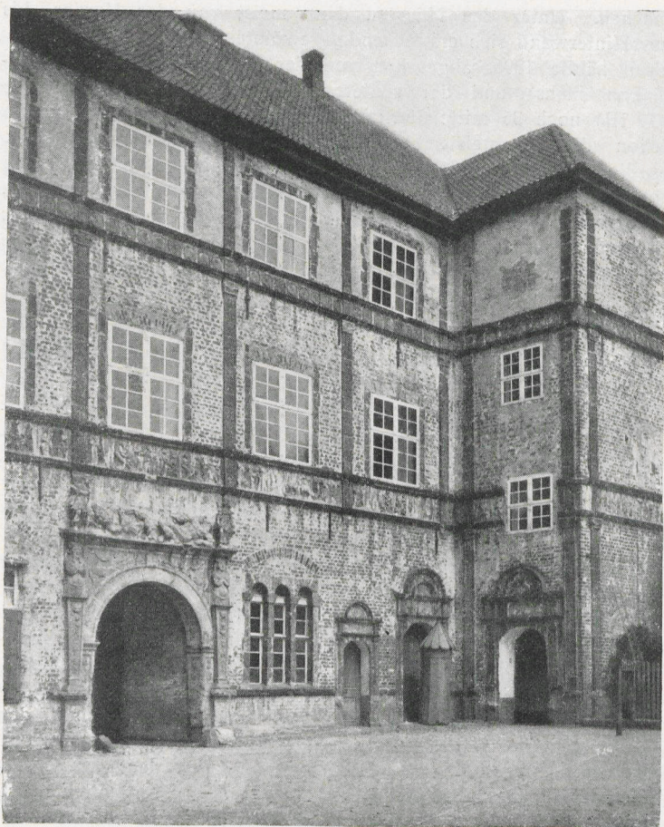
Der Fürstenhof vor der Wiederherstellung, Hofansicht (Aus Stiehl, Backsteinbauten, Jul. Hoffmann, Stuttgart)
