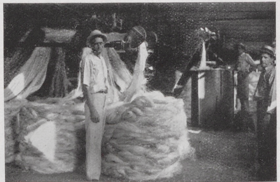
Abb. 29 In der Fabrik der Compañia de Jarcia de Matancas. Verarbeitung der Faser in der Seildreherei
