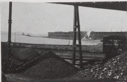
Abb. 23 Verladeanlagen für Eisenerze in Ashland (Wisconsin) am Südgastade des Oberen Sees bestimmt für Erze der südl. davon gelegenen Gogebie Range. (Transport über die Seen nach Chicago 1250 km, nach Buffalo 1500 km)
