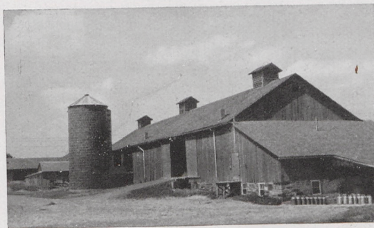
Abb. 16 Große Stallscheune (Rückseite mit Auffahrt und Silo) in Amana-Mitte (Iowa). Der aus Feldsteinen gemauerte Stall für 200 Rinder unter der Scheune
