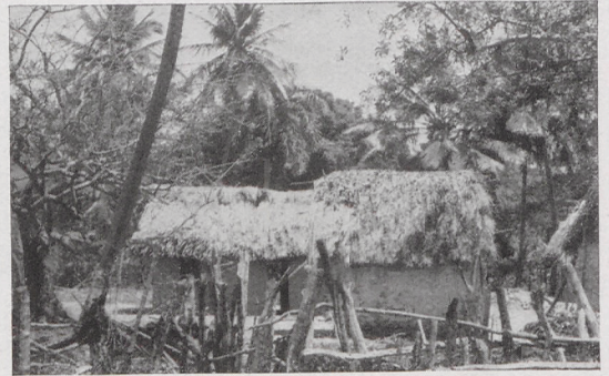
Abb. 40 Negerhütten. Lehm- und Strohbau mit Strohdach, unter Palmen und Fruchtbäumen in Nord-Haiti
