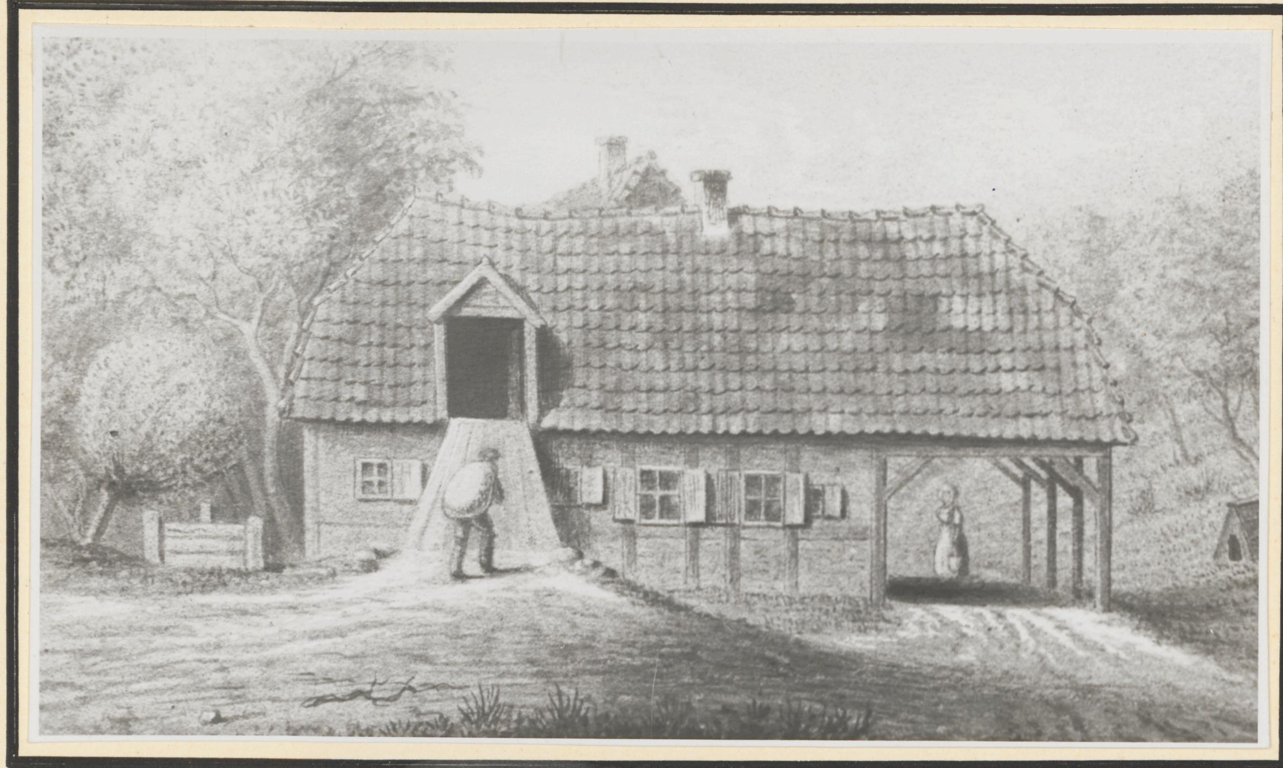
Die Pass'sche Møstarmühle an der Doberaner Chaussee zu Rostock um 1850.
