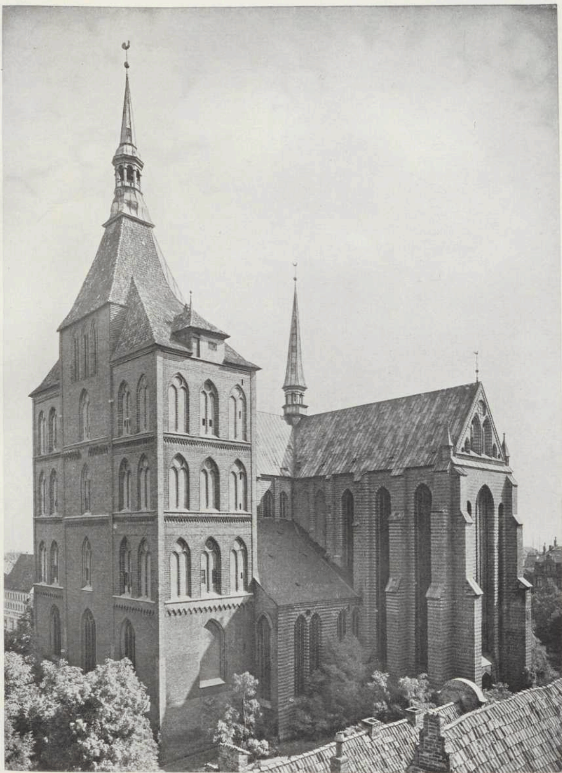
Abb. 2. Marienkirche von Südwesten.
