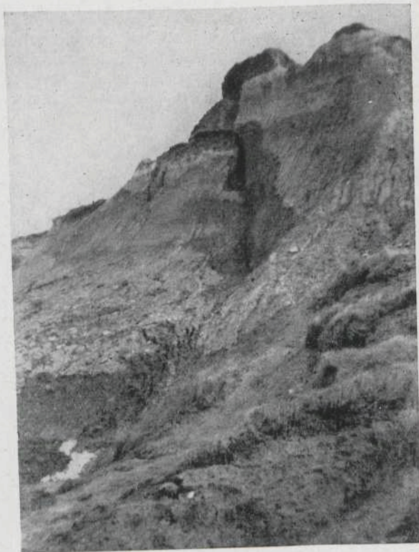
Abb. 7 Teil des Hohen Ufers im Abrutsch.
