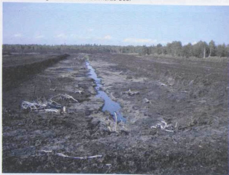
Abb. 9: Vorbereitung der Vernässung auf Feld B+C.
