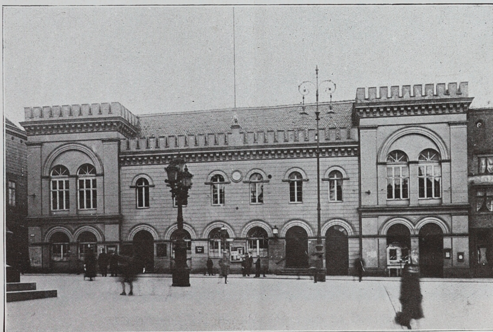
Rathaus. über dem Durchgang: Geschäftsräume der Ersparnis-Anstalt von 1834—1857.
