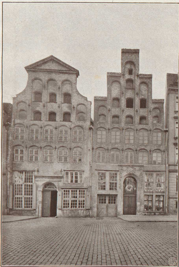
Tafel 15. Lübecker Häuser. Das linke mit klassizistisch verändertem Giebel; in beiden Wohnräume nachträglich eingebaut. Gute Beispiele für die Kleinkunst der Türen; s. S. 137. Phot. von Prof. Struck (Lübeck).
