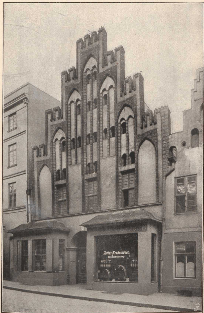
Gotisches Siebelhaus in der Großen Wasserstraße.
