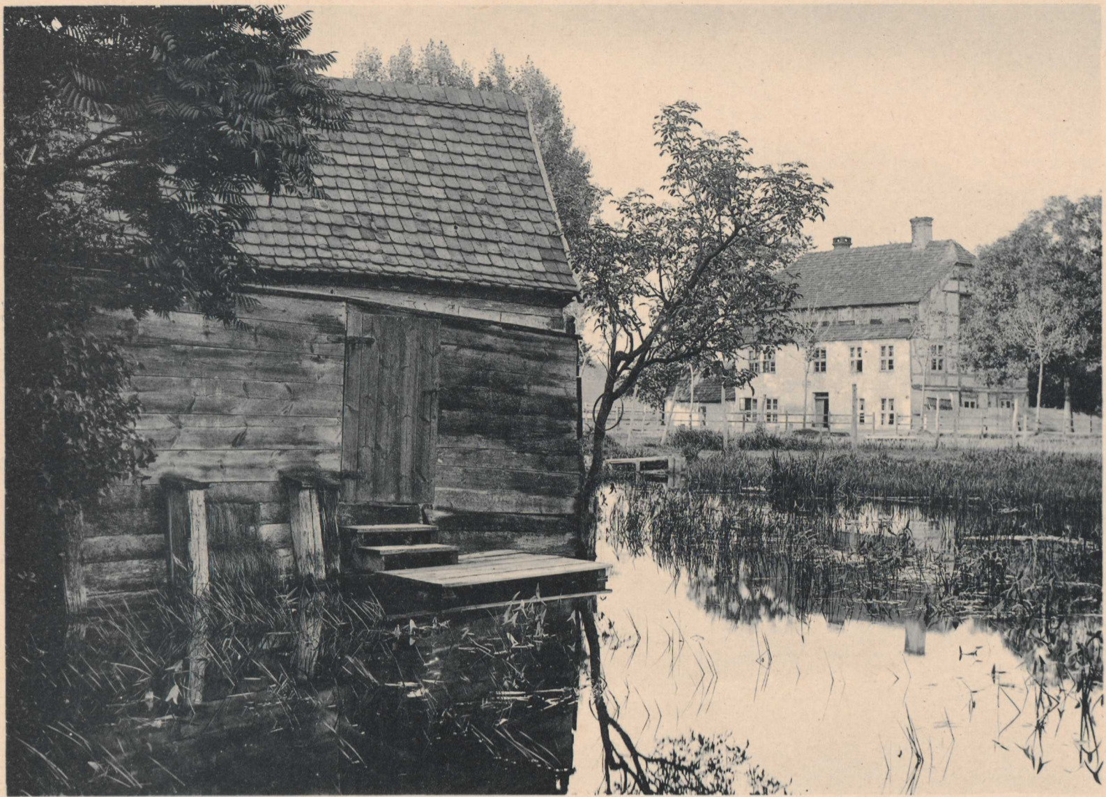
Bei einer alten Wassermühle.
