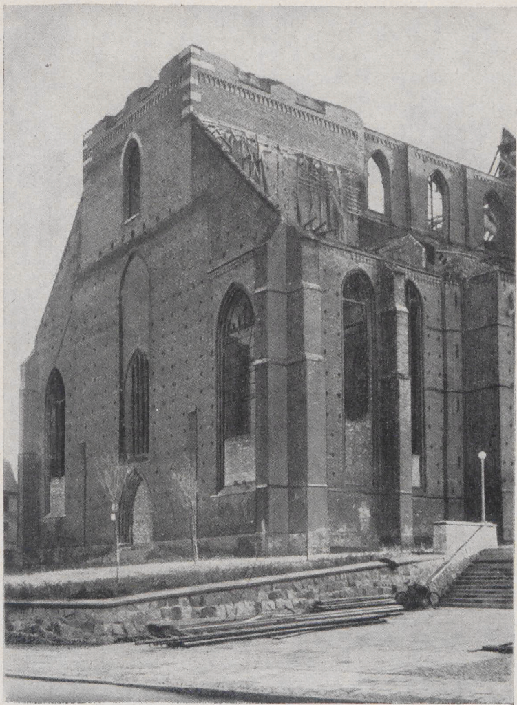
Außenansicht von Südwest (Turm) nach der Zerstörung
