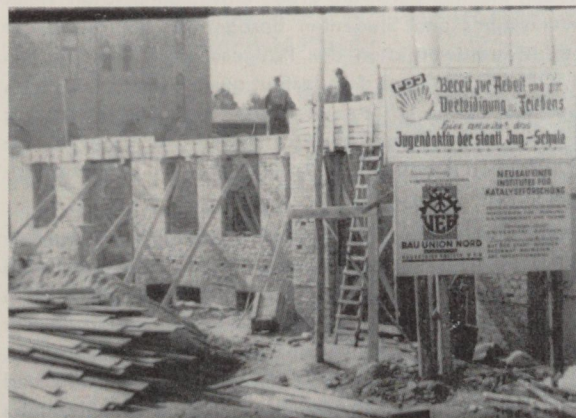
Der Rohbau des Katalyseinstituts entsteht
