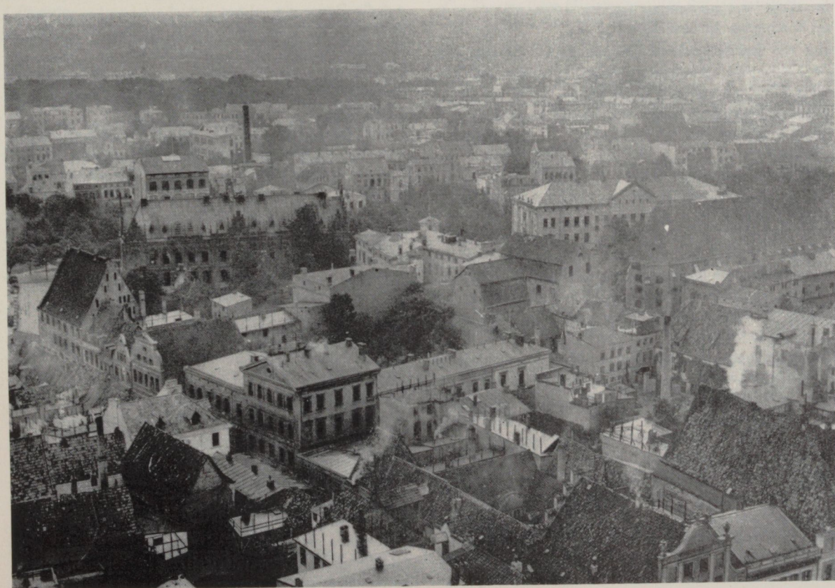
Gesamtsicht des Chemischen Instituts der Universität Rostock (Aufnahme 1934)
