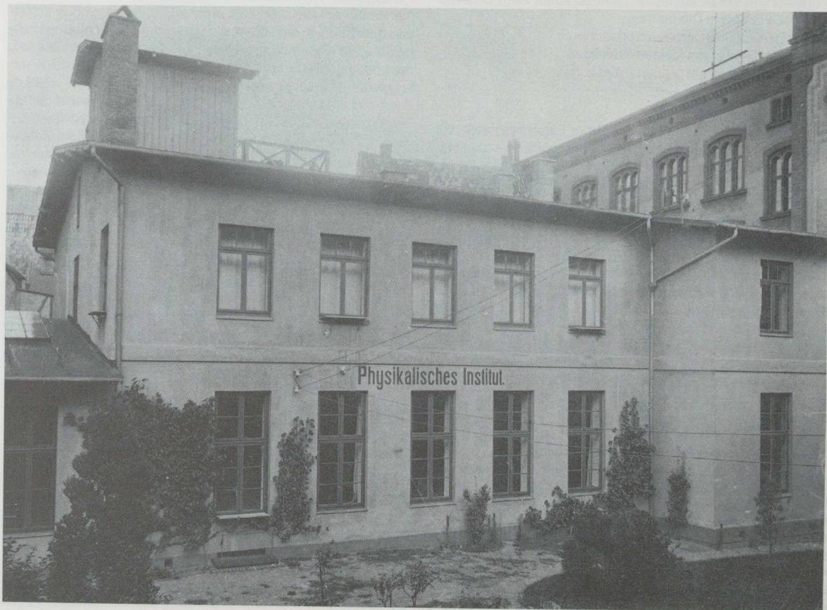
Außenansicht des alten physikalischen Instituts im Jahre 1895 mit vorderem Anbau. Auf der Rückseite des Originalfotos hat Prof. Matthiessen 1895 folgendes vermerkt: „Das physikalische Institut. Nach seiner baulichen Erweiterung aufgenommen von Photograph Kramer. Invent Cap. XXI. No. 28“.
