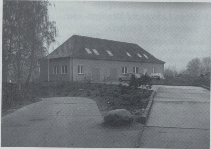
Abb. 1 Maschinenhaus - Speziallehrgebäude für Maschinenkunde, errichtet Ende der 80er Jahre
