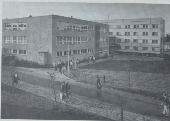
Abb. 4 Lehr- und Funktionsgebäude, erbaut um 1980, mit der Hochschulbibliothek in der zweiten Etage
