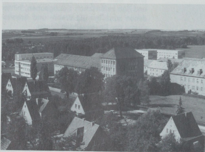
Abb. 2 Blick auf das Lehrgebäude 2 (mit Turm), Lehr- und Funktionsgebäude (links), im Hintergrund rechts die Wohnheime 10 und 11
