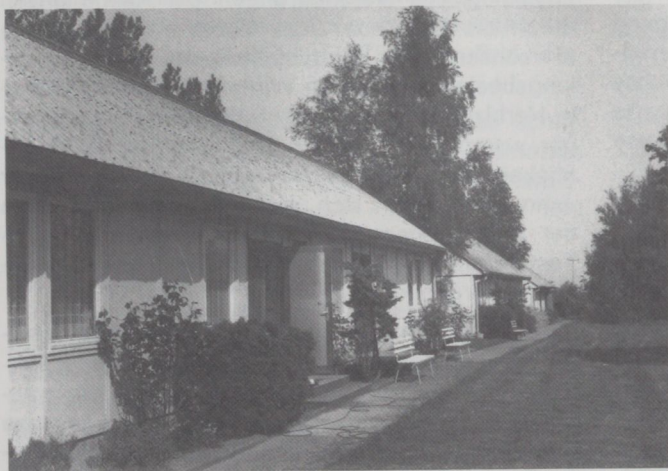
Abb. 6 Die drei Gebäude der Station Boiensdorf, errichtet 1970. Mittleres Haus: Labor- und Unterrichtsgebäude, davor und dahinter die Unterkunftsgebäude
