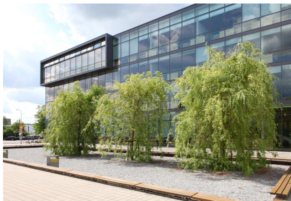
4.103: Blick vom Portal Richtung Einsteinstraße (im Hintergrund links).
