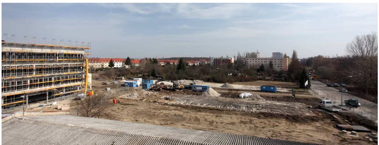
4.120: Die Baracken auf dem Grundstück des Physikneubaus sind so gut wie verschwunden. 26.03.2010.
