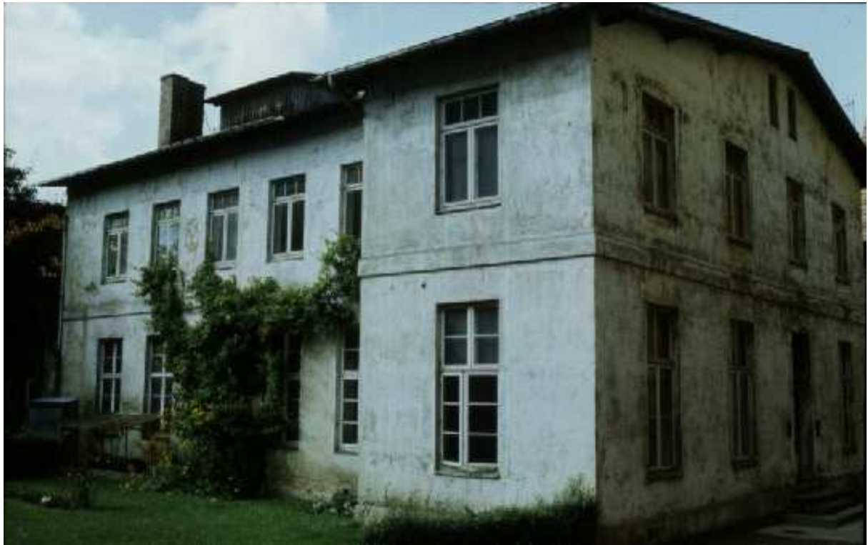
1.18: Außenansicht des ersten Physikalischen Instituts auf einem Foto aus dem Jahre 1985. Die dringend notwendige Renovierung (u. a. Erneuerung der Dachaußenhaut einschließlich Dachrinnen) erfolgt erst nach der Wende im Jahre 1990/91. Die Inschrift „Physikalisches Institut“, obwohl in diesem Bild durch die Rankpflanzen verdeckt, ist noch viele Jahrzehnte (bis zum Abriss) gut zu erkennen, wie der Autor (RM) durch Betrachtung aus seinem damaligem Arbeitszimmer im Theorie-Flügel des Universitätshauptgebäudes bestätigen kann. Der Schriftzug ist wahrscheinlich durch den wilden Wein gut geschützt worden. Dieter Bojarski, Praktikumsmitarbeiter, berichtet, dass er selbst Weintrauben erntete und zu Versuchszwecken verarbeitete.
