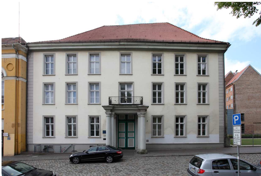
4.81: Ehemaliges Herzogliches Palais, erbaut 1714 von Leonhard Christoph Sturm nach Plänen von Reutz und Hammerstein. Der Zugang zum Saal im angrenzenden Saalgebäude erfolgt durch dieses Palais. Im Erdgeschoss ist die AG Klaus Henneberger untergebracht.
