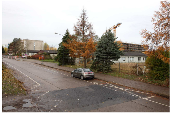
4.114: Blick entlang der Einsteinstraße Richtung West auf die Baracken auf dem Gelände des zukünftigen Physik-Neubaus im November 2009.
