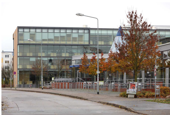
4.99: Blick auf Mensa und Bibliothek entlang der Einsteinstraße von Osten.
