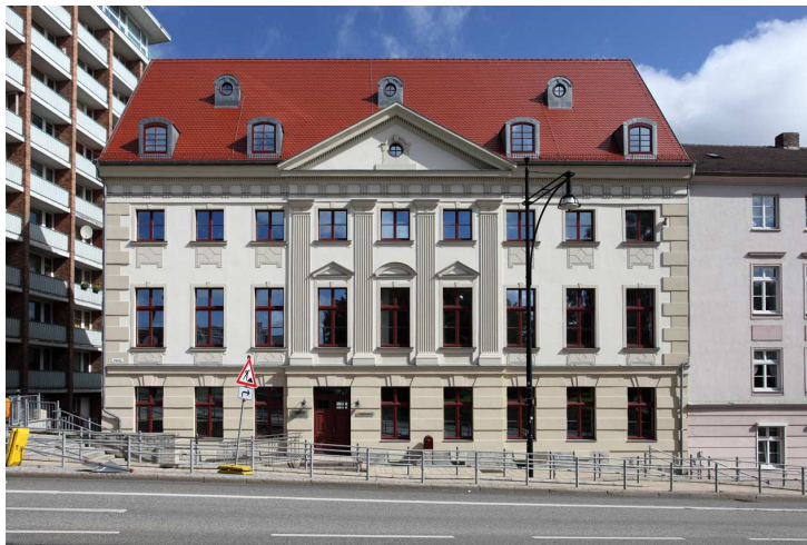
4.88: Das Gebäude Vogelsang 14. Hier war seit 1960 und bis 2002 die Didaktik der Physik (zuletzt Hans Erich Riedel) untergebracht. Dieser Zustand endete mit dem Verkauf des Gebäudes; erst der Käufer nahm eine dringend erforderliche Renovierung vor. Die Aufnahme entstand viel später, nämlich im Juni 2009.
