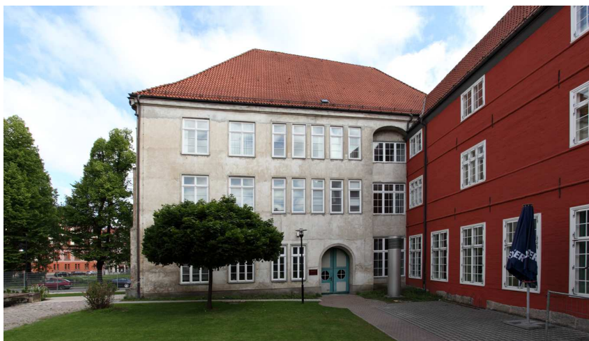
4.82: Rückfront des Herzoglichen Palais. Unter dem Gebäudeteil rechts befindet sich der „Studentenkeller“.
