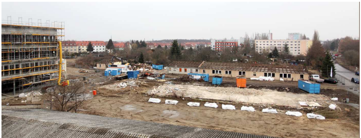
4.119: Abbrucharbeiten an den Baracken auf dem Grundstück des Physikneubaus. 19.03.2010.
