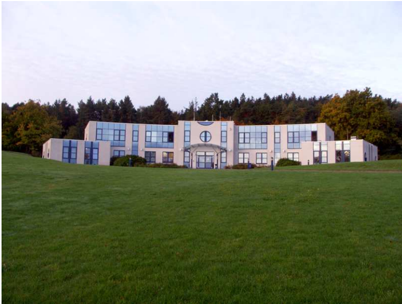
4.132: Das Leibniz-Institut für Atmosphärenphysik liegt am Nordhang der Kühlung oberhalb von Kühlungsborn. Das Institut besteht hier seit 1951; der im Bild gezeigte Neubau wurde am 19.08.1996 eingeweiht.
