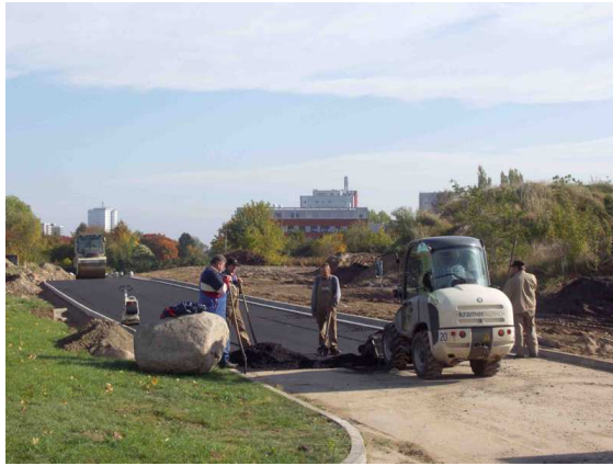
4.109: Am 10.10.2008 erhält die nördliche Erschließungsstraße ihre Fahrbahndecke.
