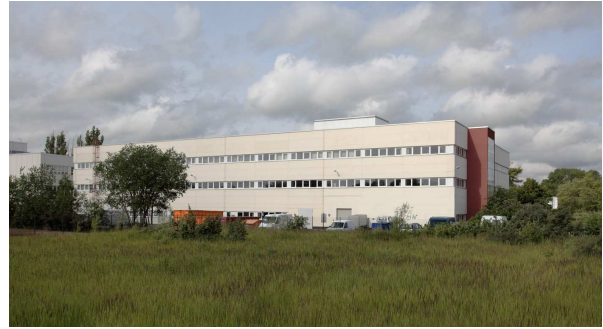
4.127: Das Gebäude in Schutow, Blick von Ost.
