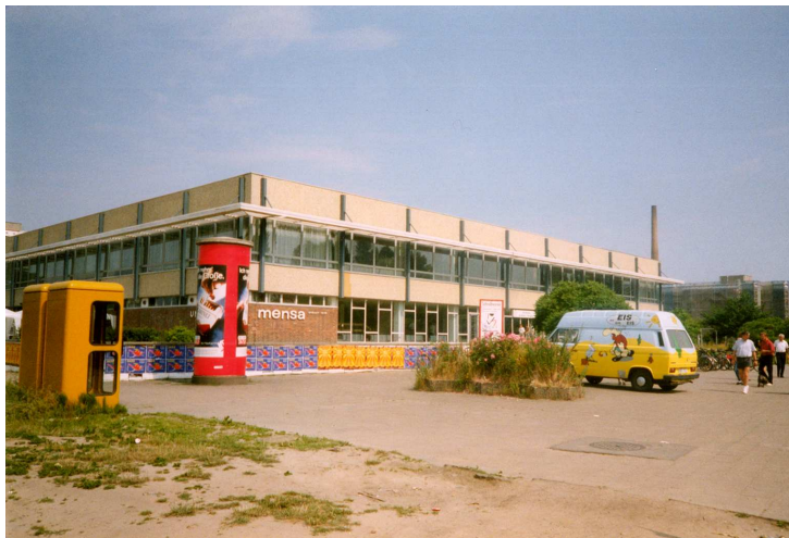
4.97: Die Alte Mensa stand auf dem Eckgrundstück Südring/Albert-Einstein-Straße. Ihr Abriss 2001 schafft Platz für den Neubau der Bibliothek. Foto ca. 1997 von Marion Pauer.
