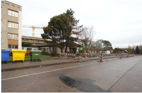
4.113: Blick entlang der Einsteinstraße Richtung Ost auf die Baracken auf dem Gelände des zukünftigen Physik-Neubaus im November 2009.
