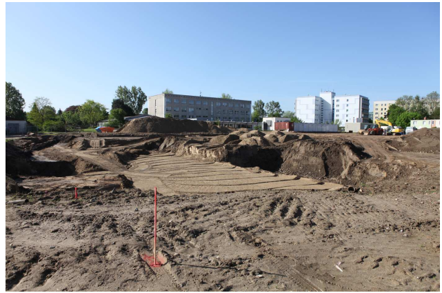
4.110: Am 08.05.2009 sind die Baugruben für den Neubau des Informatik-Gebäudes weitgehend fertig ausgehoben; einen Monat nach dieser Aufnahme findet die offizielle Grundsteinlegung statt.
