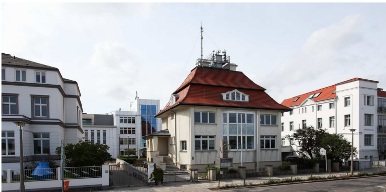
4.134: Zum Gebäude des Instituts für Ostseeforschung gehört diese Villa an der Seestraße, direkt gegenüber der Strandpromenade. Dahinter ist der neuere Gebäudeteil zu sehen.
