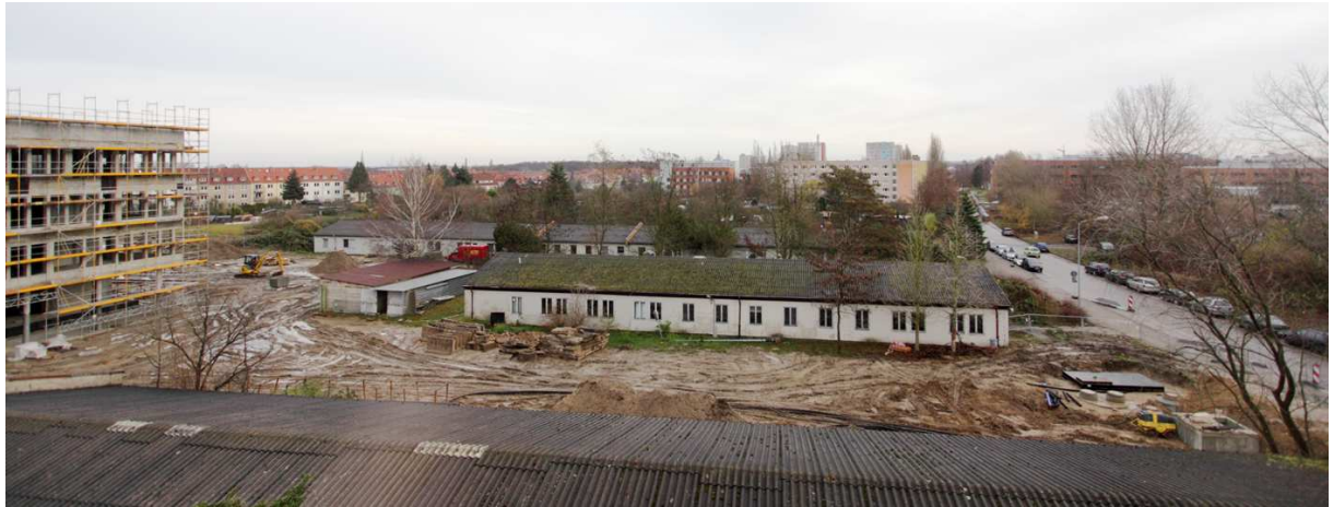
4.118: Blick auf die Baracken auf dem Grundstück des Physikneubaus am 27.11.2009.
