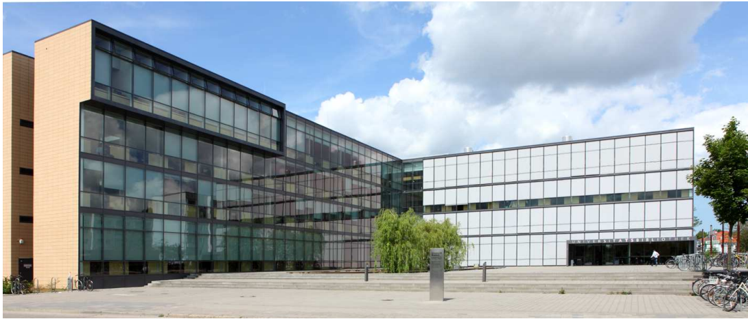
4.101: Die neue Universitätsbibliothek Albert-Einstein-Straße 6 (Ecke Südring), auf dem Grundstück der früheren Mensa (siehe Bild 4.97).
