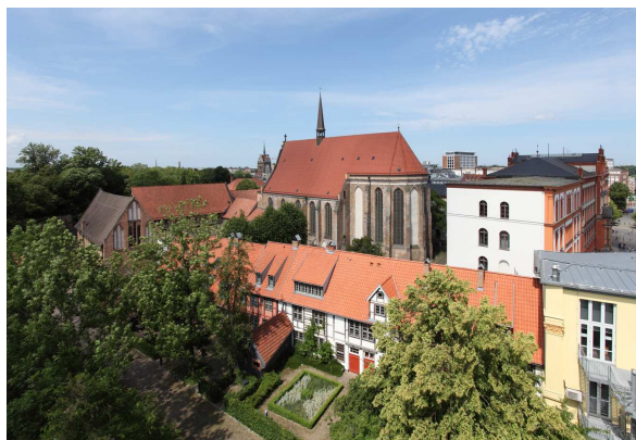
4.31: Blick vom Turm auf die Universitätskirche.
