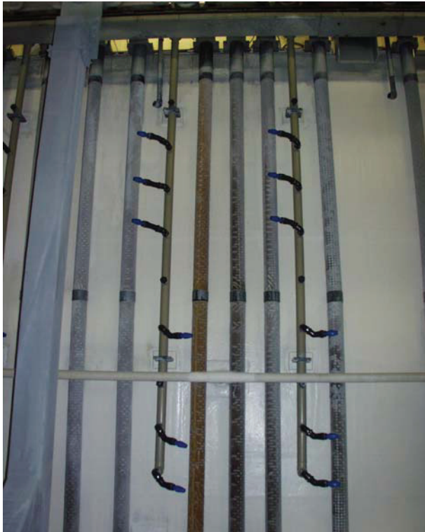
Abb. 11.2-3 Detailansicht seitliche Düsenrohre mit Lechler-Düsen
