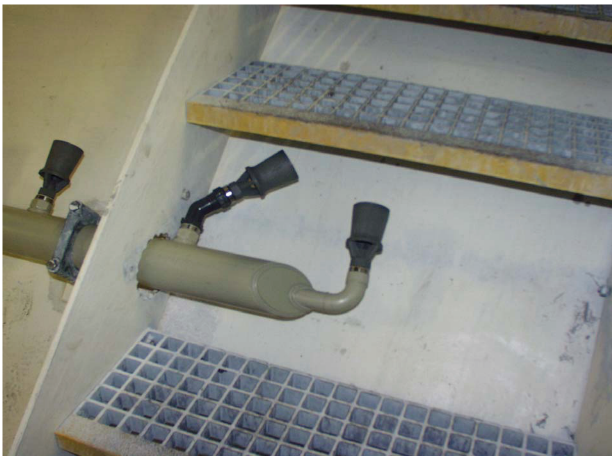
Abb. 11.2-5 Detailansicht Optimierung Bodenflutung
