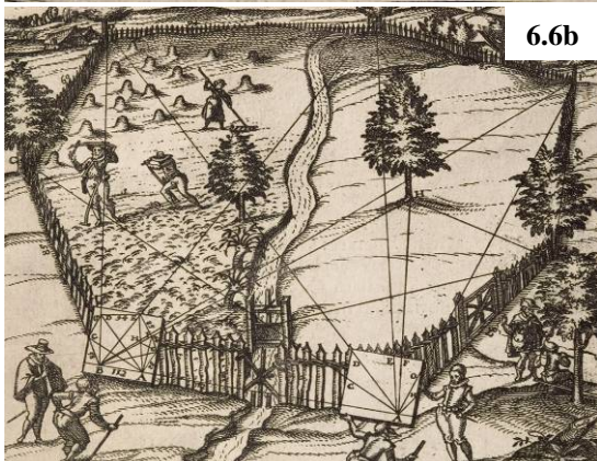
Abb. 6.6a und b: Messtischeinsatz, dargestellt von SCHWENTER [1618] und ZUBLER [1607]
