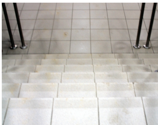
Abbildung 21 Treppe in einer Mensa ohne Treppenstufenmarkierungen (Foto M.Schmoger)
