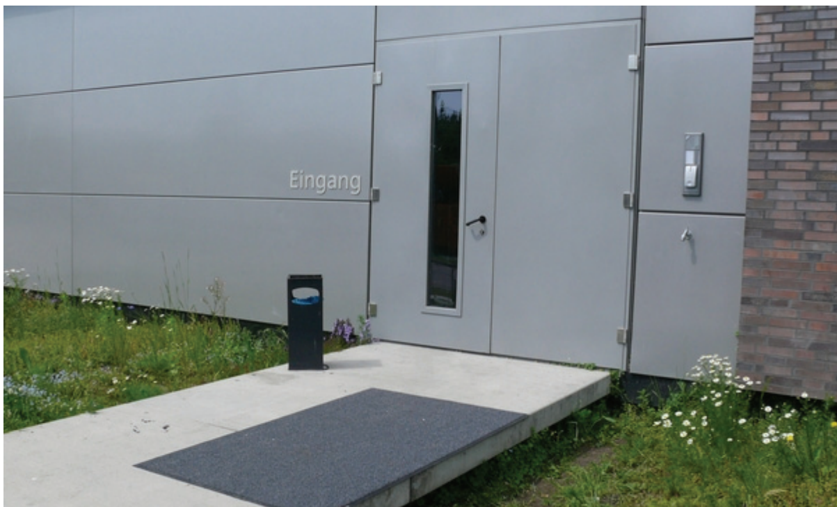
Abbildung 13 Eingangssituation an einem Nebeneingang mit Rampe, aber ohne Handlauf, Anrollkanten, die Klingel ist unerreichbar. (Foto D. Kröplin, K. Strübing)
