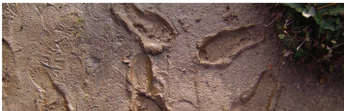
Abbildung 11 Freiflächengestaltung mit wassergebundenen Oberflächen, die nicht bei jeder Witterung gut begehbar und berollbar sind (Foto M.Oest, S. Tegtmeyer)
