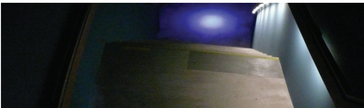
Abbildung 17 schwach ausgeleuchtete und schlecht markierte Treppe in einem Ausstellungsbereich (Foto D. Kröplin/ K. Strübing)
