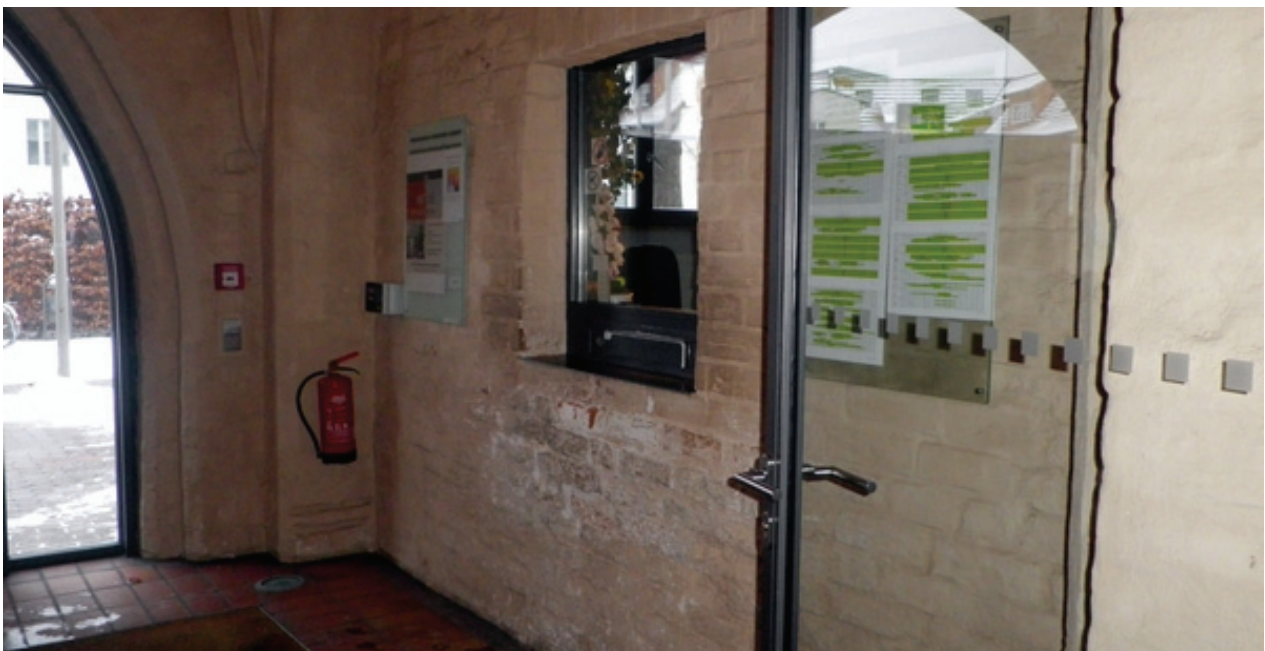
Abbildung 27 Haupteingang zu einer Hochschule mit einer für sitzende Personen unerreichbaren Pförtnerloge mit reflektierender Verglasung und ohne Hinweise auf eine induktive Höranlage (Foto S. Lenke)
