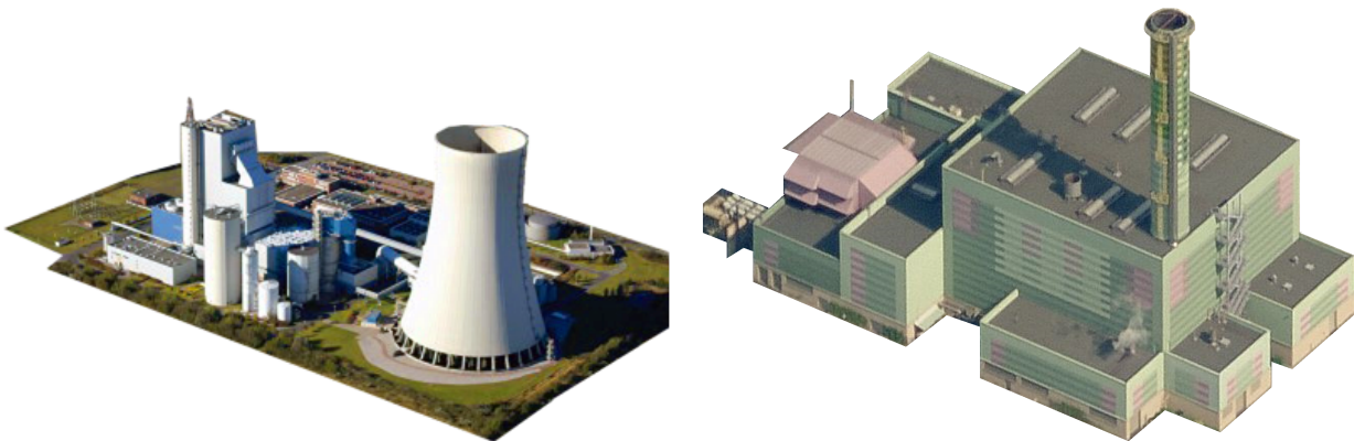
Abbildung 2.1: Untersuchte Kraftwerke - Steinkohlekraftwerk Rostock (links) [50] und GuD-Anlage Mainz Wiesbaden (rechts) [5]
