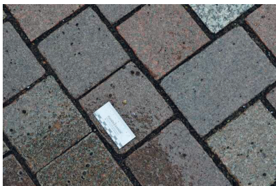
Abbildung 2: Enge Fuge, die nicht verfüllbar ist
