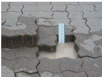
Abbildung 1: Stehendes Wasser in Fuge und Bettung
