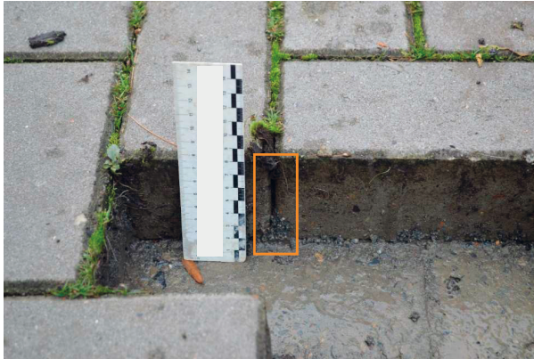
Abbildung 25: Probestelle 1 – Oberflächlich ist die Fuge visuell geschlossen, im Fugenquerschnitt ist ein Hohlraum (oranges Rechteck) deutlich sichtbar
