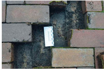
Abbildung 11: Belastete Probestelle, Fugenmaterial befindet sich unter dem Stein
