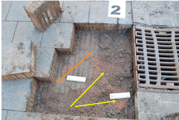
Abbildung 29: Probestelle 2 – Verschlammte bzw. verfestigte Oberfläche der Bettung (anthrazitfarben) im belasteten Bereich (oranger Pfeil), ursprüngliche Bettung besitzt einen rötlichen Farbton (gelbe Pfeile)
