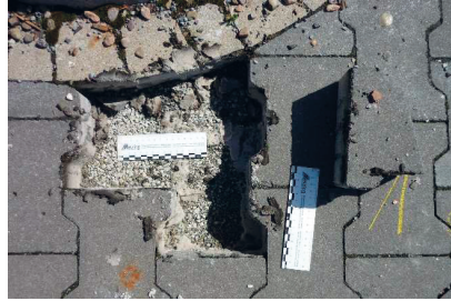
Abbildung 6: Splitt als Bettungsmaterial sichtbar
