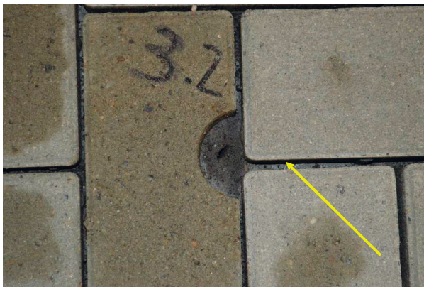
Abbildung 114: Feinanteile in der Fuge (gelber Pfeil) visuell erkennbar
