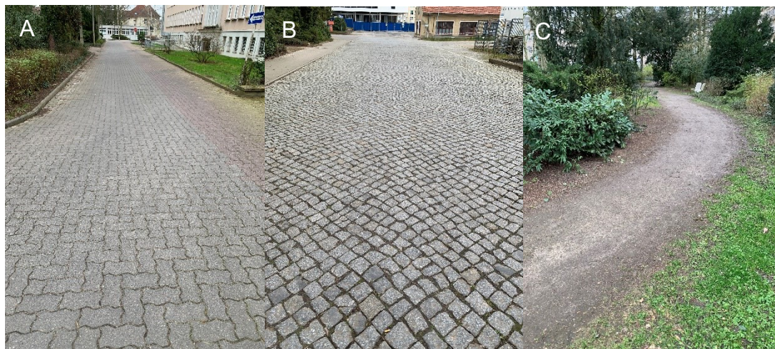
Abb. 10: Wegstrecke des Außenparcours: gepflasterter Weg (A), Kopfsteinpflaster (B) und gewachsener Grund (C)
