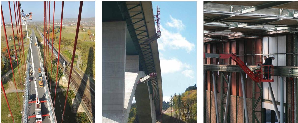
Abbildung 1.0.1: Durchführung von Brücken- und Hallenprüfungen [40, 90]
