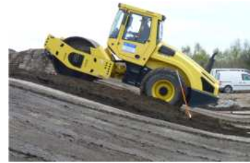
(b) Verdichtung Polder I - West
