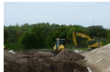
(h) Verdichtung Polder III
