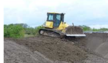
(f) Verdichtung Polder II
