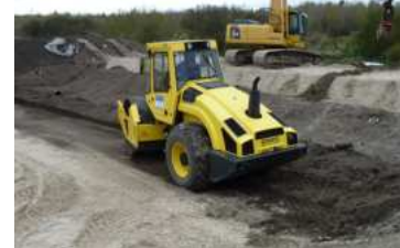
(d) Verdichtung Polder I - Ost
