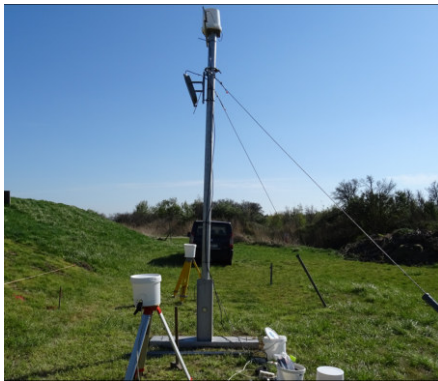
(a) Messpfahl mit installierten Kameras
