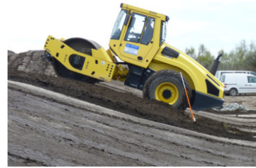
(b) Verdichtung Polder I - West
