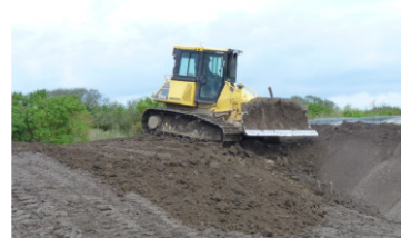
(f) Verdichtung Polder II
