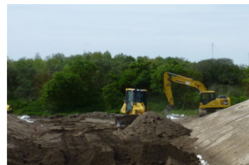
(h) Verdichtung Polder III
