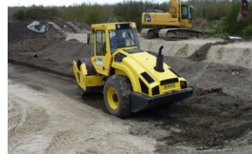
(d) Verdichtung Polder I - Ost
