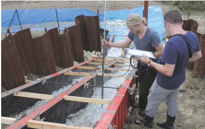
Abbildung 4-13. Prinzip der Messungen von Strömungsgrößen senkrecht zur Böschungsoberfläche. Hier: Messung der Fließgeschwindigkeit in einem Testabschnitt (Foto: unbekannt)
