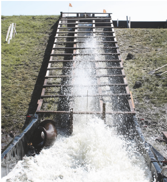
Abbildung 5-14: Versuchsdurchführung mit hergestellten Schadstellen auf und in der Böschungsoberfläche (Foto: Ricarda Neumann).
