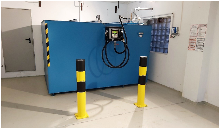
Abb. 6.2: Bodenbeschichtung und Aufkantung zur Errichtung einer Abfüllfläche
