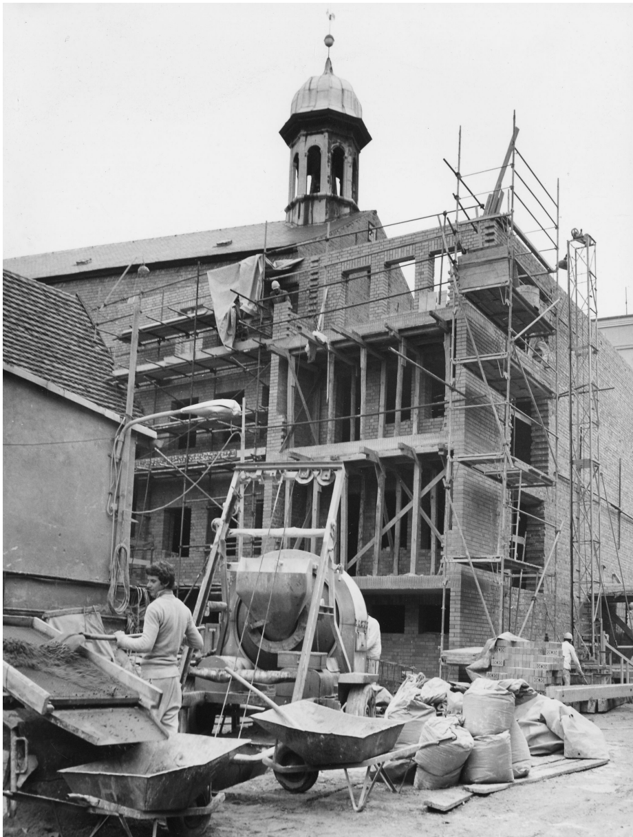
Abb. 1: Erweiterung der Kirche St. Anna, Rohbau 1984
