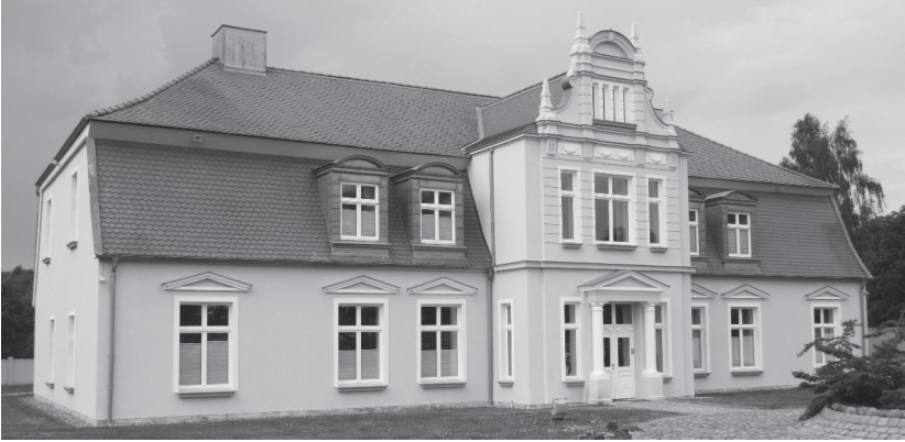
Abb. 8: Gutshaus Dolgen. Fotografie 2015 (eigene Abb.)
