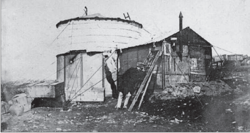
Abb. 16: Fotografisches Observatorium. Ein eiserner Turm mit rotierendem Dach und Steinfundament.
