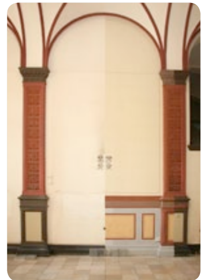
Erste restauratorische Vorarbeiten im Innern des Universitätshauptgebäudes
