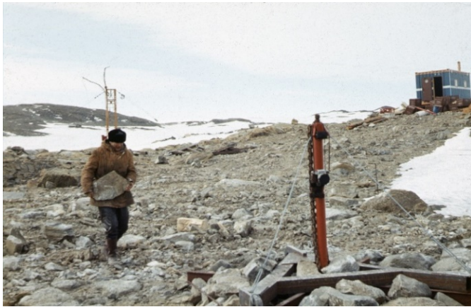
Bild 79 Wolfgang Probst beim Herantragen der Steine zur Sicherung der Abfangseile für den Sendemast
