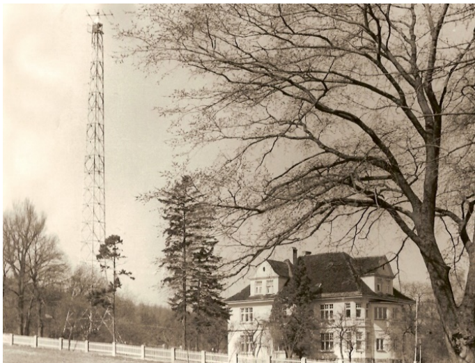
Bild 30 Der 50 m hohe Antennenturm der 33-MHz-Radaranlage
