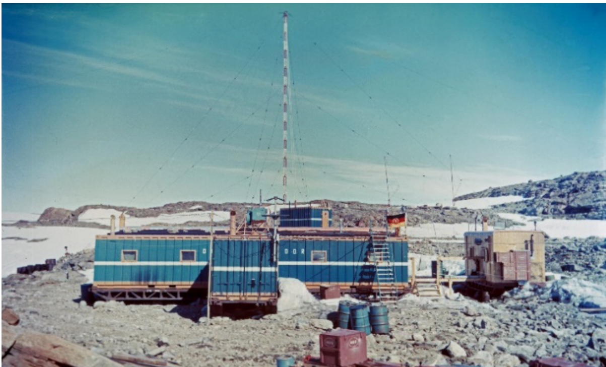
Bild 78 Die fertige Containerstation, rechts die Dieselstation, hinten der 30 m Sendemast mit Sendecontainer
