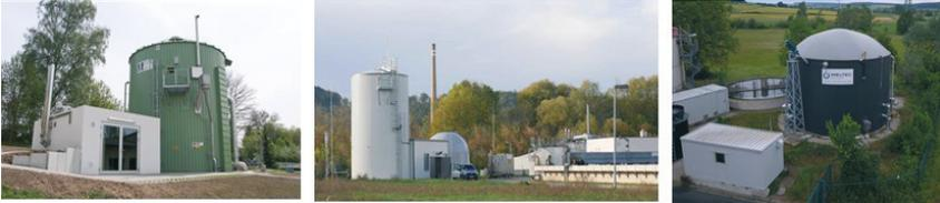
Abb. 9: Beispiel kleiner Faultürme: KomBio-Reaktor (Faulbehälter und Gasspeicher in einem) mit 200 m<sup>3</sup> Faulvolumen – Lipp GmbH [8] (Links), Areqa GmbH [9] (Mitte), Weltec Biopower GmbH [10] (Rechts)
