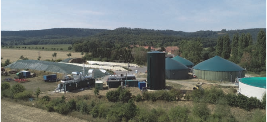
Abb 1: Beispiel-Speicherkraftwerk Wülfinghausen: Zubau BHKW 1,5 MW, Großwärmepuffer, Gasspeicher. Betriebszeit um 2.000 Jahresstunden
