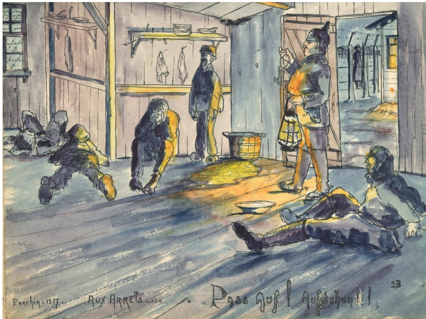
Abb. 3 Blick in den Innenraum einer Baracke im Lager Parchim. Bildnachweis: Maxime Bourrée © Collection Esther Bourrée.
