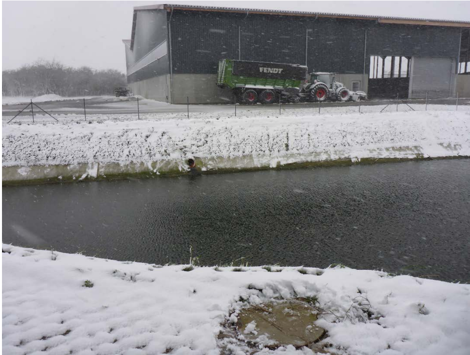
Abbildung 3: Überdachtes Fahrsilo auf dem LWB Brüel mit Speicher für das gering belastete Niederschlagswasser (hier Nutzung als Löschwasserspeicher), Foto: M. Koch
