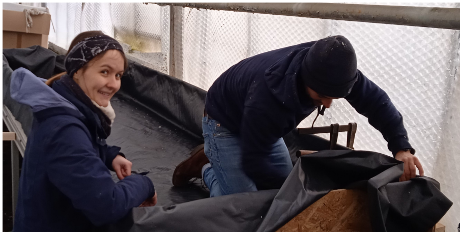
Abb. 15: Fertigung der Becken aus Baumarkt-Halbzeugen
