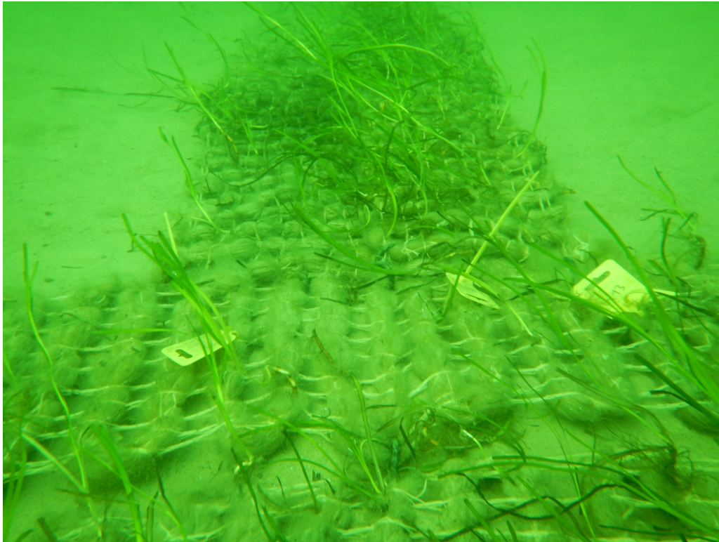
Abb. 31: Bei der Erstinstallation lagen die Aufwuchsträger auf dem Meeresboden
