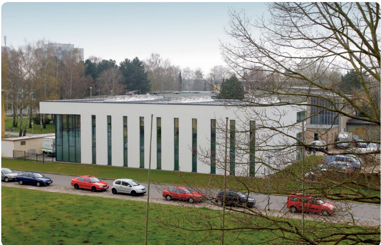
Blick auf die neue Forschungshalle der Fakultät für Maschinenbau und Schiffstechnik
