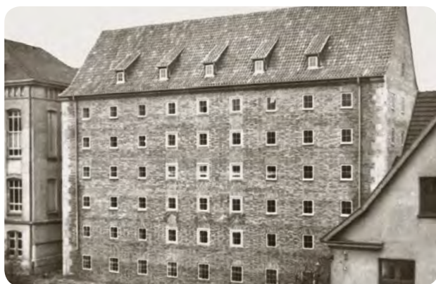
Im Februar 1939 wurde der Bücherspeicher fertiggestellt. Hier: Bücherspeicher, Hof- und Südseite, 1939
