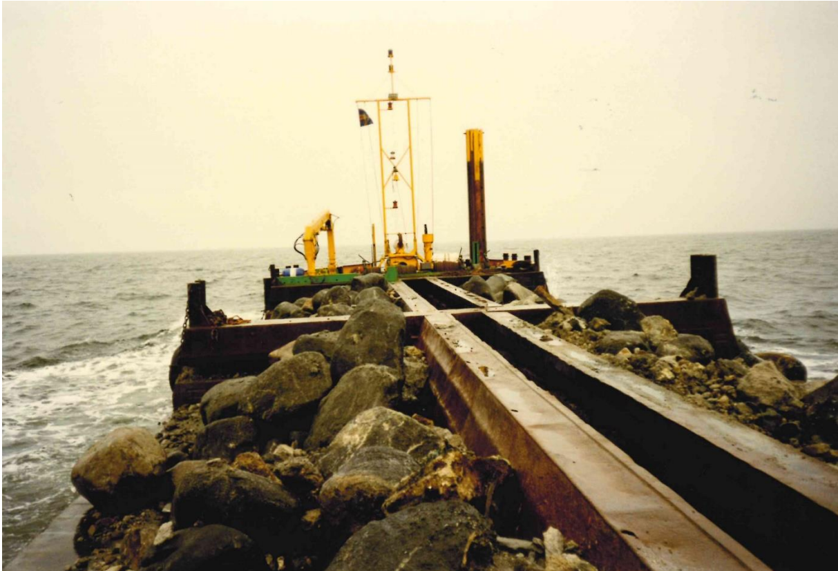
Abb. 2: Steinstürzer bei der Verklappung der Natursteine.
