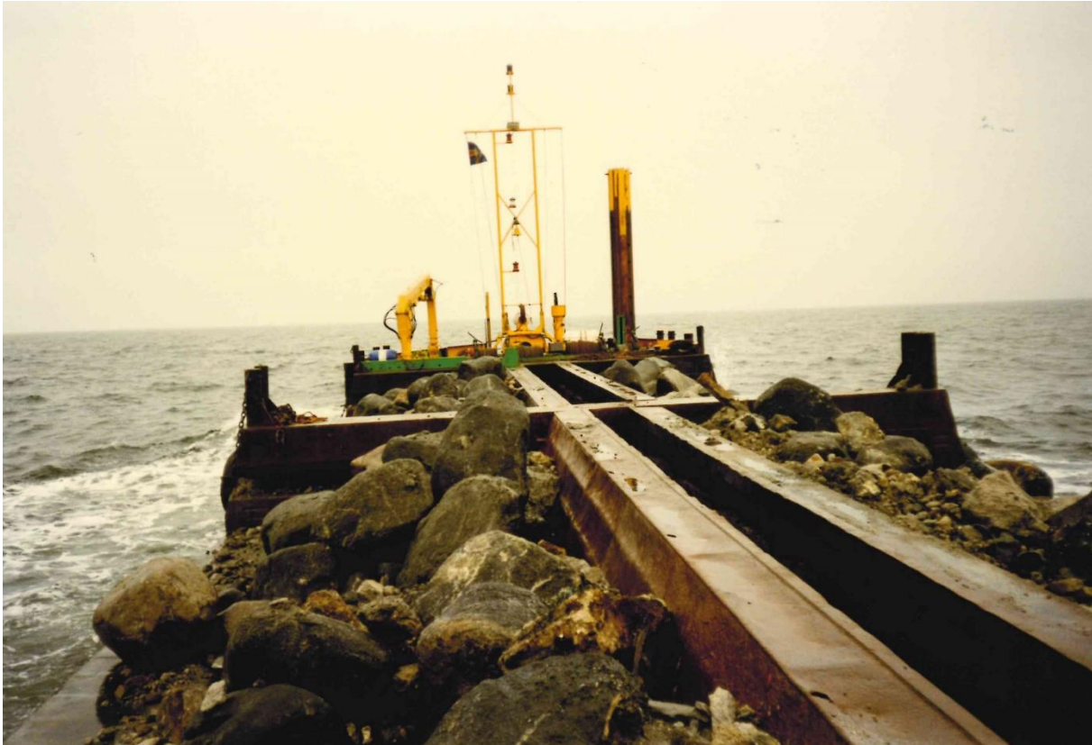
Abb. 2: Steinstürzer bei der Verklappung der Natursteine.
