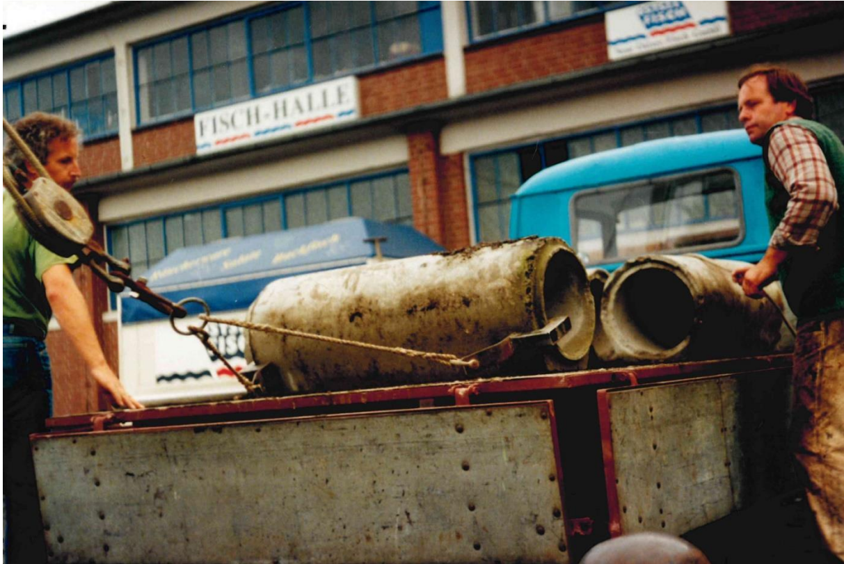
Abb. 1: Verladung der ersten Betonrohre.
