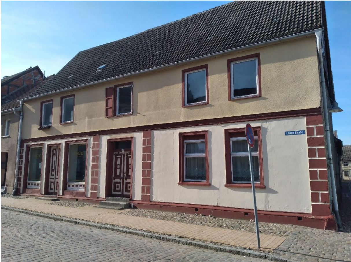
Abb. 25: Ehemaliges Geschäftshaus J. B. Cohn in der Langen Straße 48, F.-A. Tröster 2024. 53
