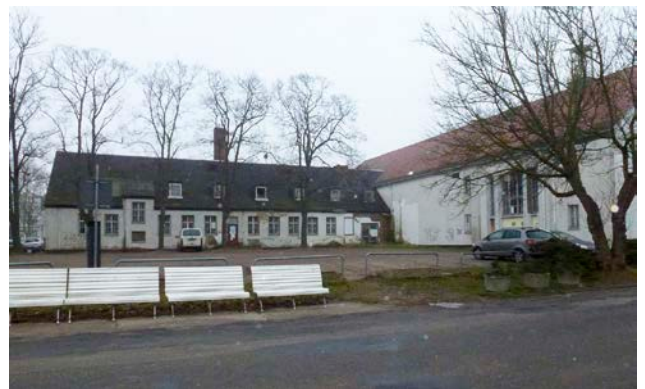
Abb. 2. Ahlbeck, Lkr. Vorpommern-Greifswald, Dünenstraße 37, Haus der Erholung, Rückseite mit ehemaligem Wirtschaftsflügel, 2015, (LAKD M-VILD, B. Gnekow).
