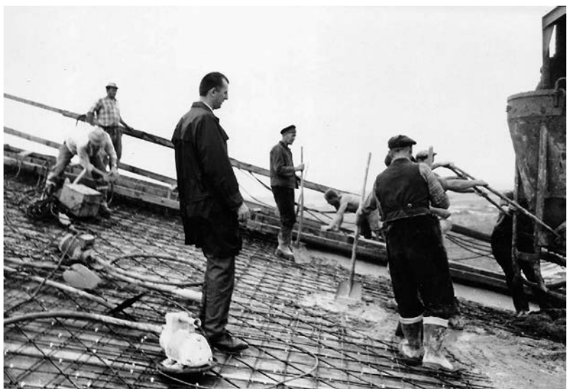
Abb. 7. Rostock, Messehalle, Betonieren der Schalenfläche, 1966.
