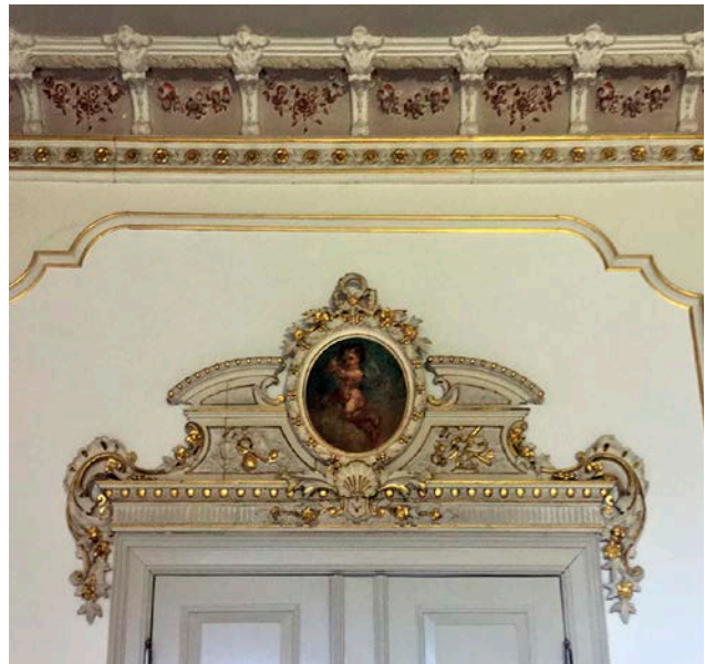
Abb. 86. Stralsund, Mühlensstraße 7, Obergeschoss, Saal, Supraporte und Stuckkehle, 2024, (LAKD M-V/LD, F. Thomas).
