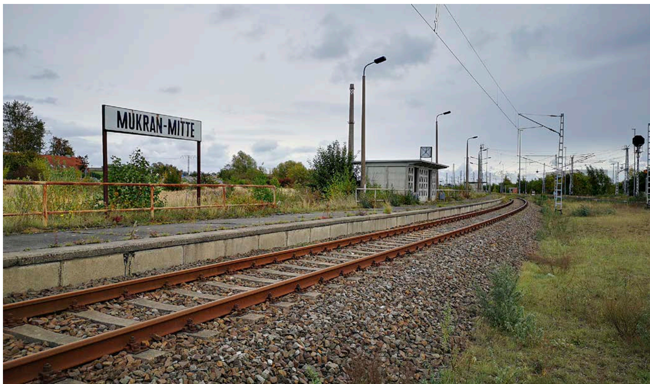
Abb. 43. Mukran, Lkr. Vorpommern-Rügen, Gelände des ehemaligen Eisenbahn-Fährhafens, Haltestelle Mukran-Mitte, von Westen, 2021, (F. Biederstaedt, Sassnitz).
