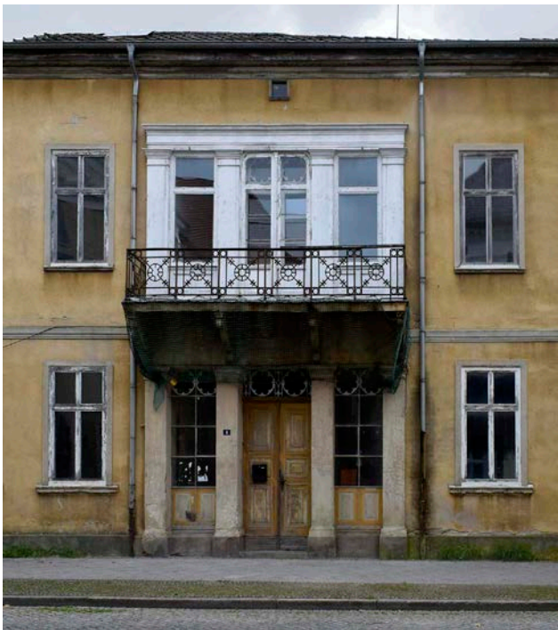
Abb. 60. Neustrelitz, Schlosstraße 6, Wohnhaus, Eingangssituation, 2021, (J. Kayser, Schönfeld).
