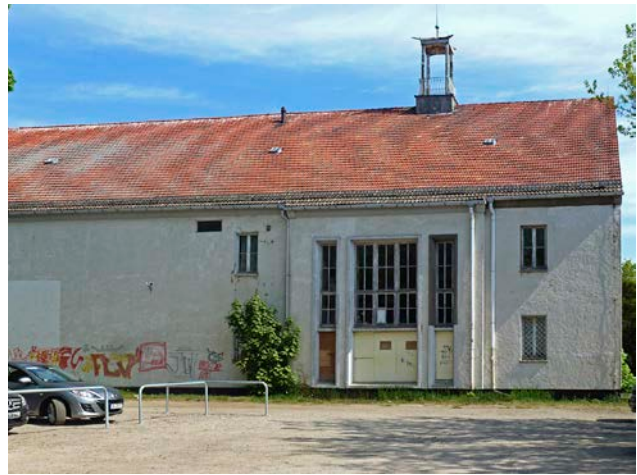
Abb. 5. Ahlbeck, Lkr. Vorpommern-Greifswald, Dünenstraße 37, Haus der Erholung, östlicher Teil der Rückseite mit Treppenhausrisalit, 2016, (LAKD M-V/LD, B. Gnekow).
