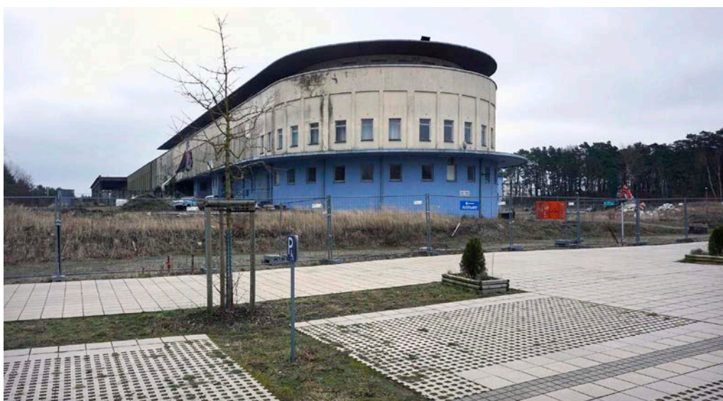
Abb. 6. Prora, Lkr. Vorpommern-Rügen, Dritte Straße 4/6, südliche Bebauung des Festplatzes, westlicher Kopfbau, 2022.
