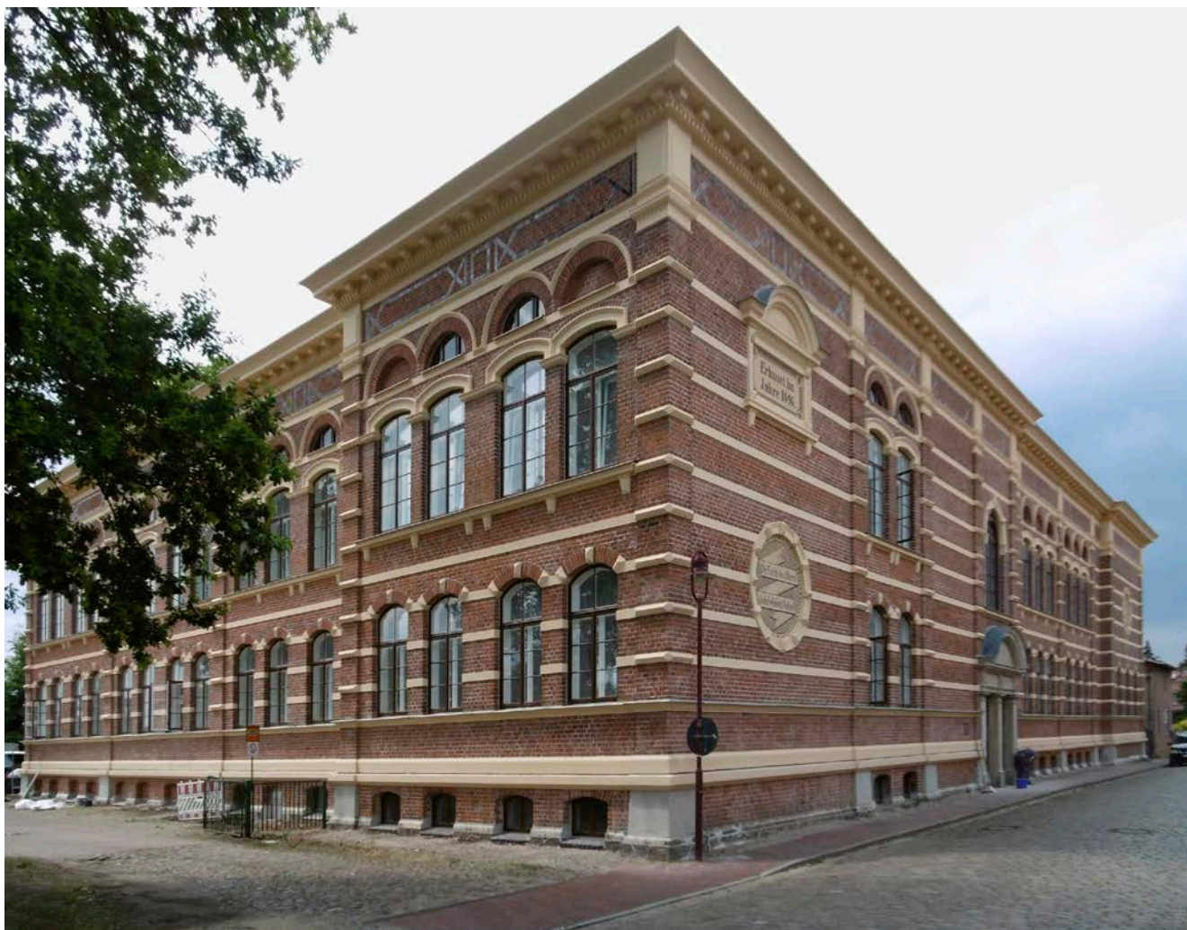
Abb. 39. Lübtheen, Lkr. Ludwigslust-Parchim, Amtsstraße 3, ehemalige Schule, 2023 (LAKD-M-V/ILD, J. Schirmer).
