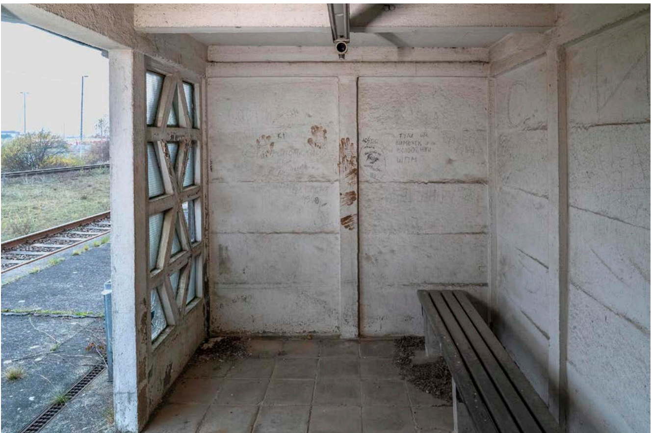
Abb. 46. Mukran, Lkr. Vorpommern-Rügen, Gelände des ehemaligen Eisenbahn-Fährhafens, Haltestelle Mukran-Mitte, nordwestliches Wartehäuschen, Inneres nach Nordwesten, 2021, (A. Bötefür, Schwerin).
