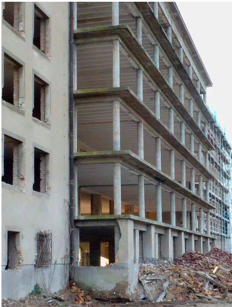
Abb. 8. Prora, Lkr. Vorpommern-Rügen, Südstrand, Block II, Liegehalle mit Rundstützen, 2015.
