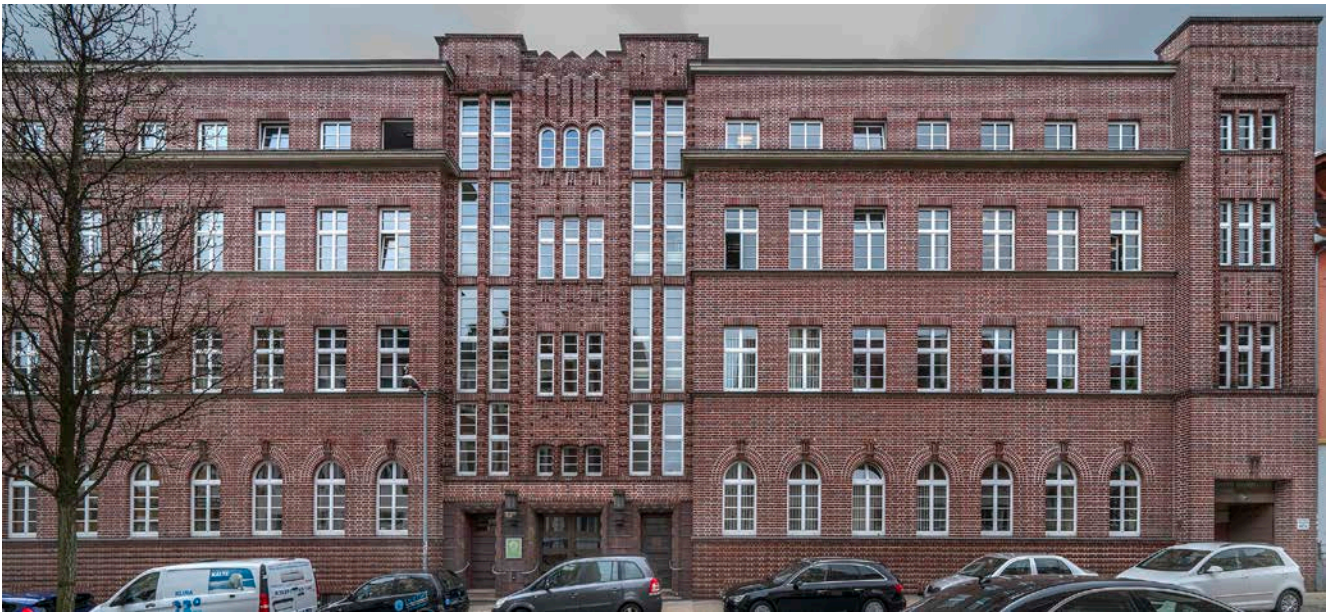
Abb. 13. Schwerin, Geschwister-Scholl-Straße 3–5, Verwaltungsbau, 2015.
