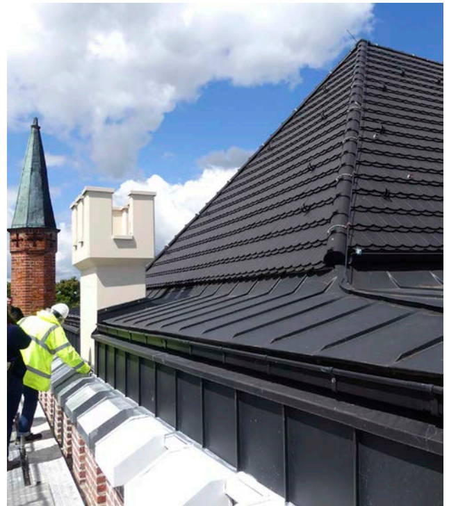
Abb. 24. Broock, Lkr. Vorpommern-Greifswald, Gutshaus, Dach, Südseite, 2024, (LAKD-MV/LD, A. Krug).
