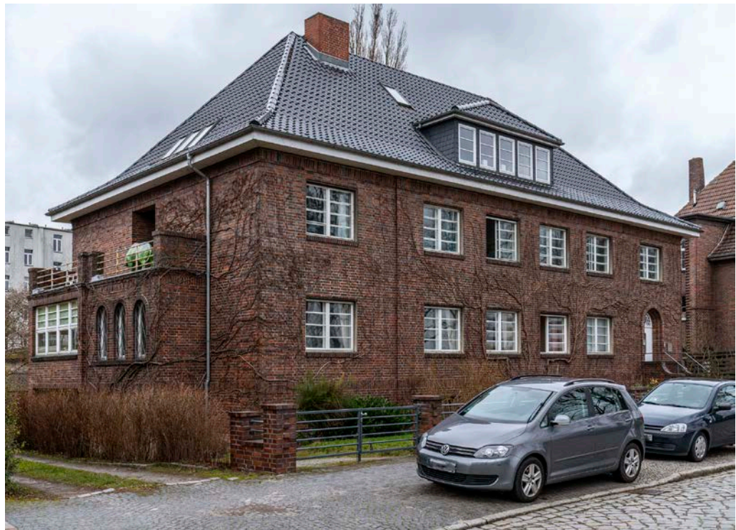
Abb. 7. Schwerin, Dr.-Hans-Wolf-Straße 3, Wohnhaus, 2019.
