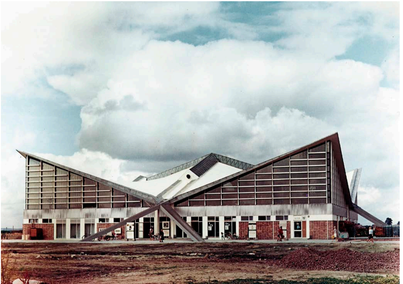
Abb. 14. Rostock-Lütten Klein, Warnowallee 25, Mehrzweckhalle, 1968.
