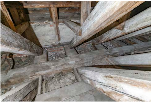
Abb. 61. Schlossstraße 6, Dachgeschoss, Balkenlage mit bauzeitlichen Sparren (Vordergrund), firstparallelem Wechsel und Stichbalken mit Zusatzsparren und Attika einer weiteren späteren Umbauphase, 2023, (J. Kayser, Schönfeld).
