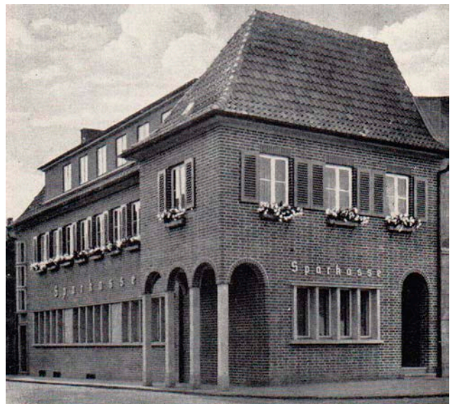
Abb. 53. Neubukow, Am Markt 12, Sparkasse, kurz nach der Fertigstellung 1936, (Heißl, Aus der Geschichte, 1937, Abb. 20).
