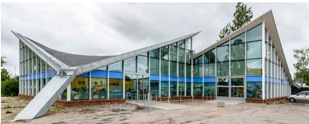
Abb. 2. Rostock-Schutow, Libellenweg 3, ehemalige Messehalle, 2023.
