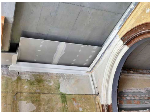
Abb. 21. Broock, Lkr. Vorpommern-Greifswald, Gutshaus, Foyer, Stahlbetondecke am Übergang zur Wand mit Stülerschen Gestaltungselementen und Probefläche zur Deckenausbildung, 2023, (LAKD-MV/LD, A. Krug).
