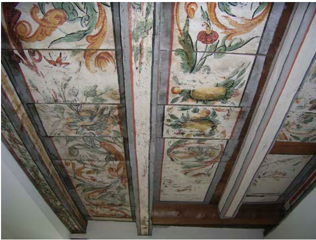
Wismar, Lkr. Nordwestmecklenburg, Mecklenburger Straße 12, Kemladen, Holzbalkendecke, 2008, (LAKD M-V/LD, J. Schirmer).
