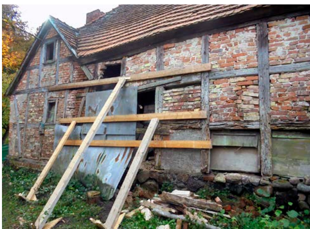
Abb. 58. Neustrelitz, Lkr. Mecklenburgische Seenplatte, Burg 3, Stallgebäude, 2022 (LAKD-M-V/LD, J. Schirmer).
