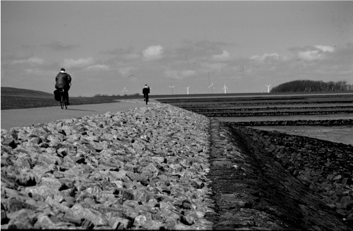
Abb.1 Steinpackungen sichern den unteren Hang eines Erddeiches, direkt davor Wattflächen mit Buschlahnungen. Aufnahme bei Tideniedrigwasser. Bei normalem Tidehochwasser ist der dunkle Bereich des Steindeckwerkes überspült. Insel Föhr, Näsborn 2004
